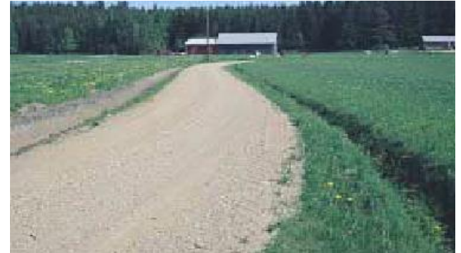
Kulutuskerrosmateriaalia on riittävästi
