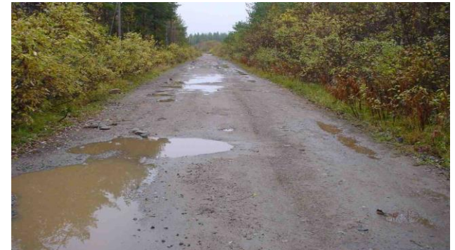
Kulutuskerrosmateriaalia ei ole ollenkaan ja muutakin työtä näyttää olevan
