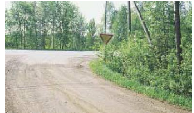
Liittymässä vesakko rajoittaa näkemää
