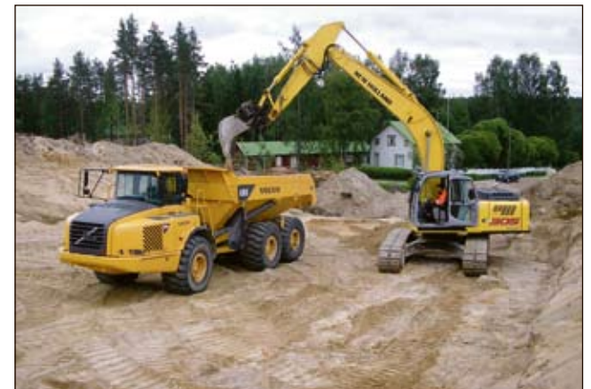
Tien oikaisukohteessa leikattiin mäkeä pois.
