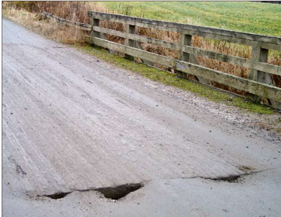
Vesi on liikenteen ohella tien vaurioiden suurin aiheuttaja. Kuvassa eroosio on alkanut syövyttää sillan maatikia.
