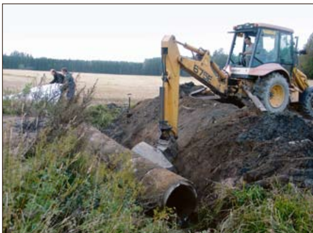
Yksityistien perusparantamisessa valvojan rooli on tärkeä. Hän on tiekunnan edustaja työmaalla ja valvoo työn sujumisen suunnitelmien mukaan. Usein hän joutuu tekemään nopeitakin päätöksiä uusien havaintojen perusteella ja siksi ammattitaito ei ole haitaksi.
