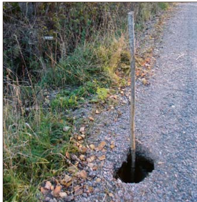
Rumpu- tai muu vaurio on jo pitkällä, kun oireet alkavat vasta näkyä tien pinnalla. Siksi tien kuntoa on syytä seurata muutoinkin kuin vain auton ikkunasta.
