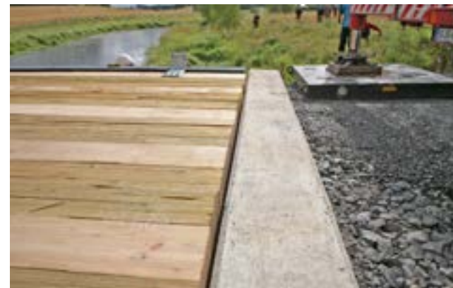
Uusi silta istahti vaivatta paikoilleen.
