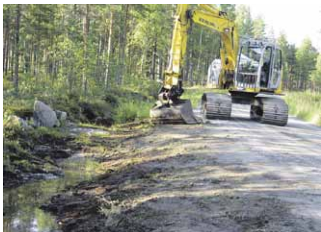
Sivuoja perataan hankkeessa lähes koko teiosan matkalta.
