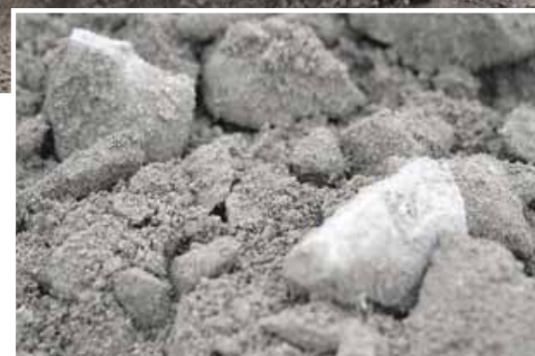
Tuhka tuo kalliomurskeeseen lisää hienoainesta. Tuhka-murskeseos tiivistyy tien pintaan kovaksi, ja ilmeisesti myös vettä läpäisemättömäksi kerrokseksi. Tässä 0–32 mm kalliomurskeeseen on sekoitettu 15 % tuhkaa.
