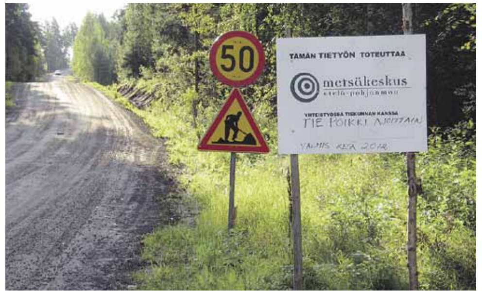
Perusparannustyöt haittaavat väistämättä liikennettä.
