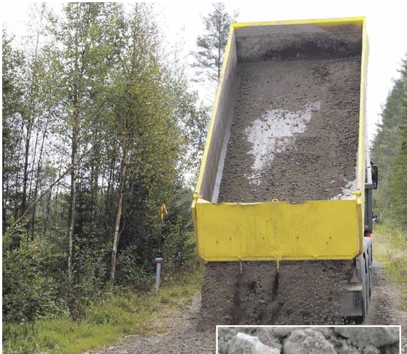
Kalliomurske, johon on sekoitettu 15 % tuhkaa, tulee vielä hyvin alas auton lavalta. Tuhkan määrän lisääntyessä paakkuuntuminen sekä lavalle tarrautuminen lisääntyvät.
