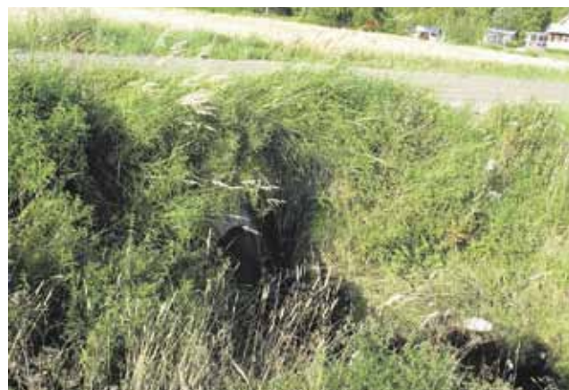
Puron vedet ovat löytäneet jotenkuten tämän ikääntyneen betonirummun pään...
