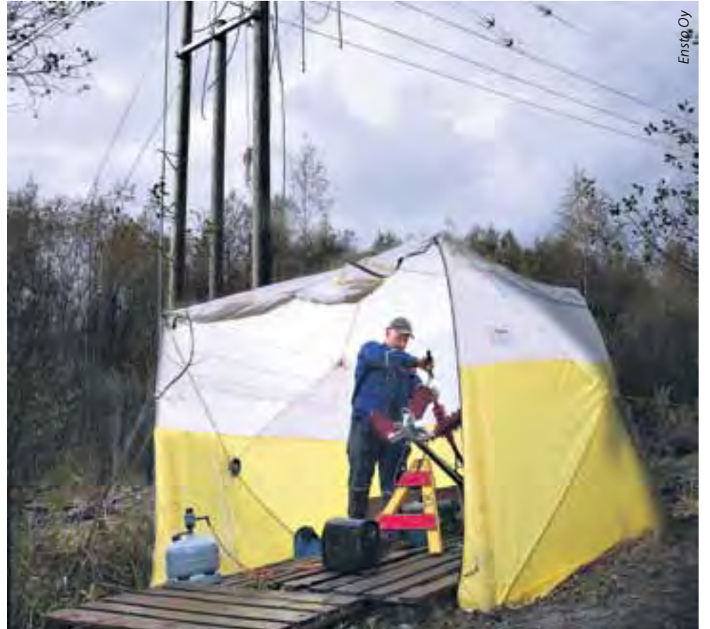
Sähkön toimitusvarmuus paranee, kun siirrytään ilmajohdoista maakaapeleihin.
