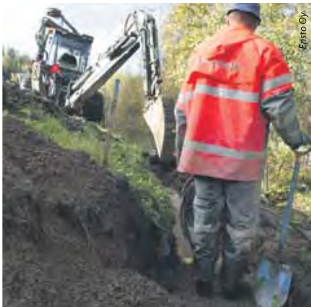
Maakaapelin asennustyö meneillään.
