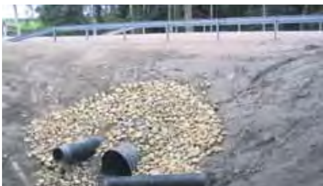
Leppojan rumpu, halkaisija 1,2 m, valmiina. Tulvapatki 400 mm ja rummutetun sivuojan putki 315 mm.
