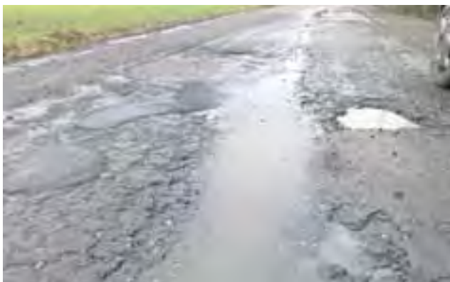
Raskas liikenne, kosteus ja tierungon kantavuuspuutteet ovat rikkoneet päällysteen liikennettä haittaavaksi. Jatkuva päällysteen paikkaaminen ei ole oikea toimenpide.
