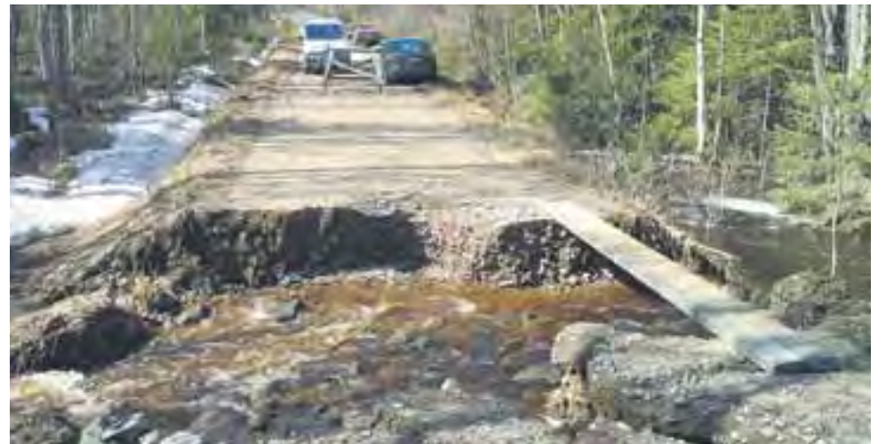
Kevättulva katkaisi tien usean metrin matkalta. Murtunut kohta jouduttiin ylittämään lankkuja pitkin ennen kuin uudet rummut saatiin asennettua
