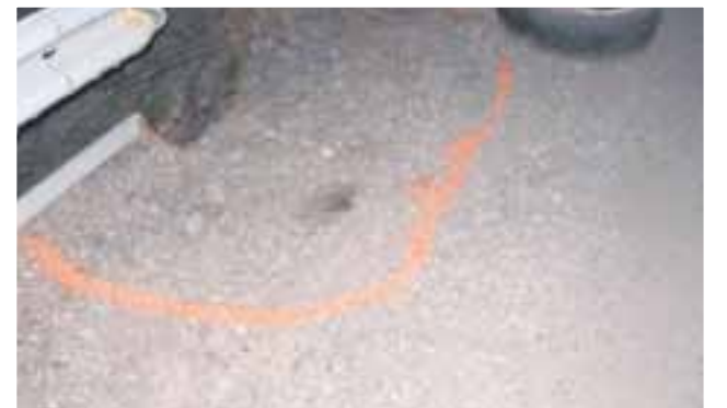
Leppojan sillan päällä havaittu reikä.
