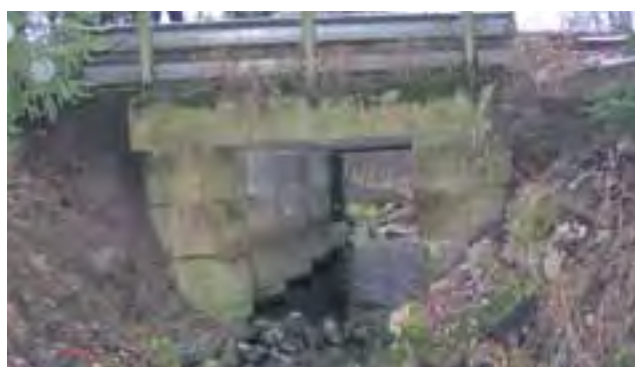
Leppojan vanha silta, maasortumat ja kaivonrengaspilarit.
