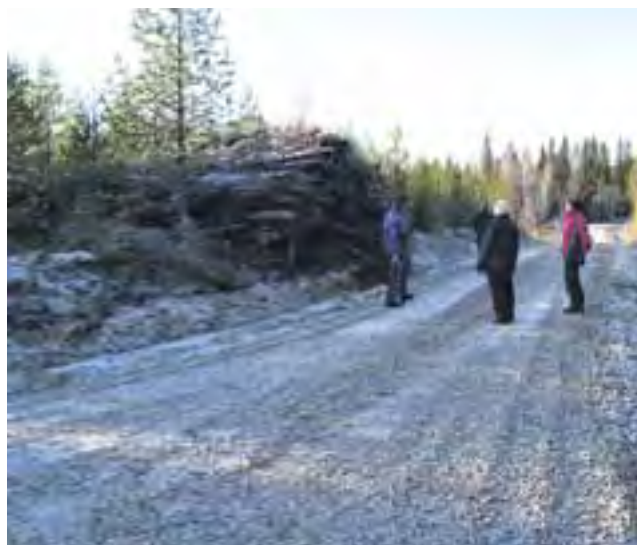
Tien runko ajettiin ensin tiekarhulla muotoon, jonka jälkeen tien sivuojat kaivettiin kaivinkoneella. Tällä tavoin päästiin parempaan lopputulokseen. Kuvassa hoitokunta arvioimassa lopputulosta. Urpo Haapalainen (vas.), Mirja Pakarinen ja Anja Heikkinen . Kauimpana Jalo Karhu tarkkailemassa tien profiilia.
