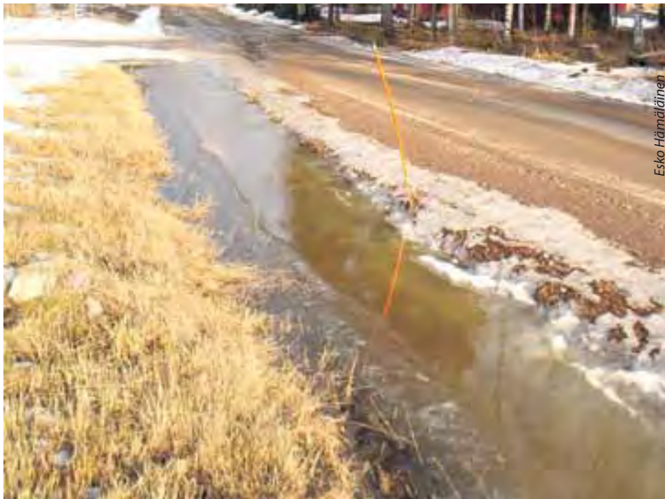
Talvella jäätyneet rummut ja sulamisvesien virtaaminen tielle on merkki siitä, että kesällä "tarttis tehrä jotain".
