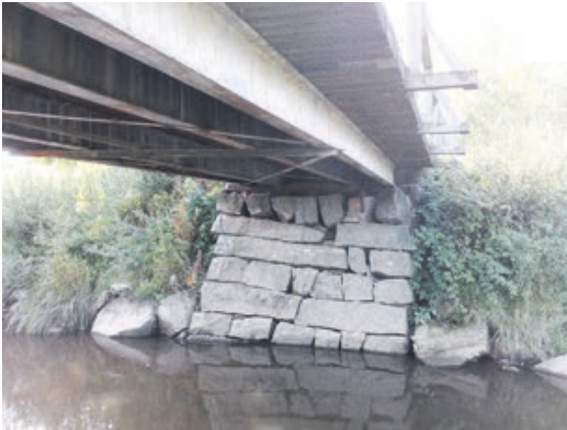
Santerin silta oli vuonna 2011 kuntonsa ja kantavuutensa takia uusimisen tarpeessa.
