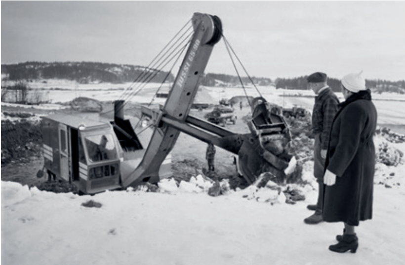
Suomen ensimmäinen moottoritie, Tarvontie, tehtiin työttömyystöinä vuodesta 1956 alkaen. Tarvontien 14,5 kilometriä oli valmis vasta 1962, eli työ kesti kuusi vuotta. Kuvassa Tarvontie rakenteilla Kasabergetin kohdalla Espoossa vuonna 1959. Jussi 65:90 -kaivinkone kaivaa tienpohjaa. Lähde: valokuvaaja Erkki Voutilainen, Museovirasto.
