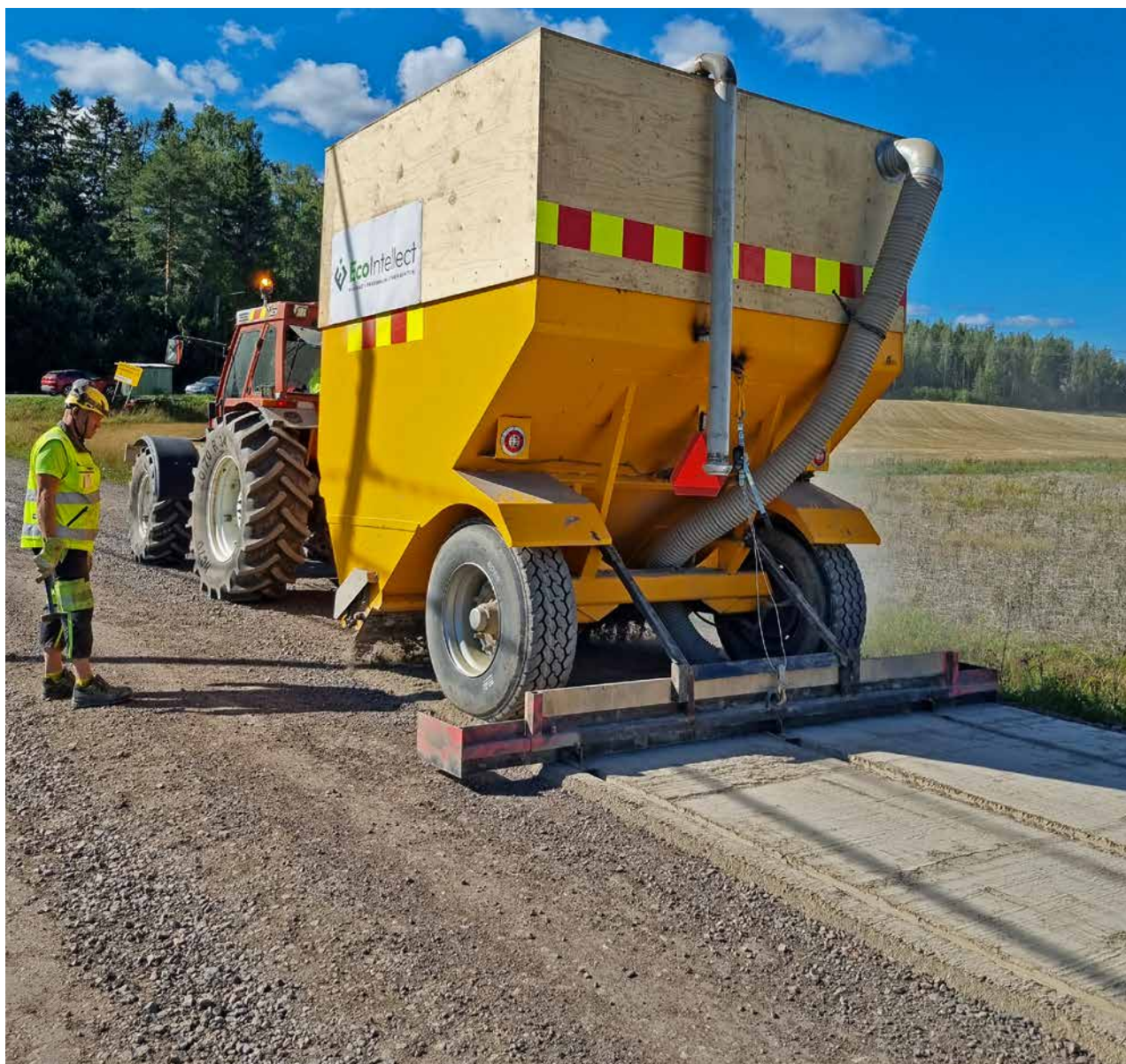
Uusiosideainetta levitetään EcolIntellectin pilottihankkeessa tien pintaan, josta se sekoitettiin seuraavaksi maakerrokseen.
