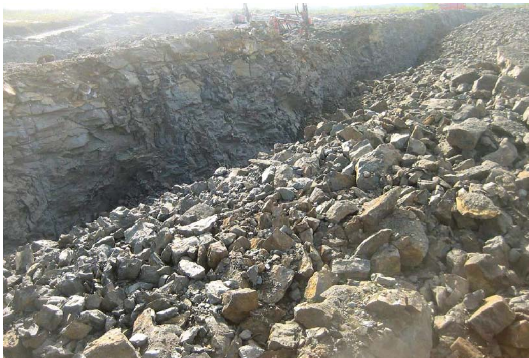
Räjäytyksessä rintausta avautunut esimerkiksi, louheen pintakerros on liian karkea. Korjaavana toimenpiteenä etutäytteen korkeuden muutos 4 metristä 2,5 metriin.
