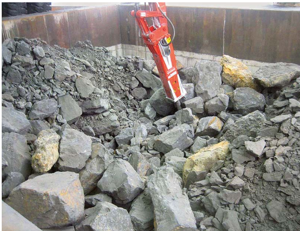
Lähtötilanne maaliskuussa 2009. Karamurskaimeen kipatun louheen karkeus vaikeuttaa murskaustyötä. Ylisuuret lohkokareet on rikottava rikotusvasaralla, jotta louhe saadaan menemään murskaimen läpi.
