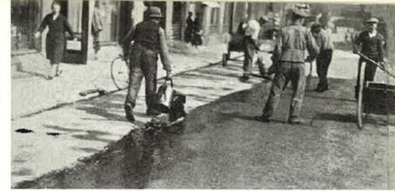
Kuva 30. Linnankadun vanhaa amiesite-päällystettä Vilpurissa pintakäsitteltään emulsiolla v. 1934, etualalla emulsion vaelu kaotokannulla, taustalla tynnyrientyhjiennuskärryt ja oik. hiekkakärryt.
