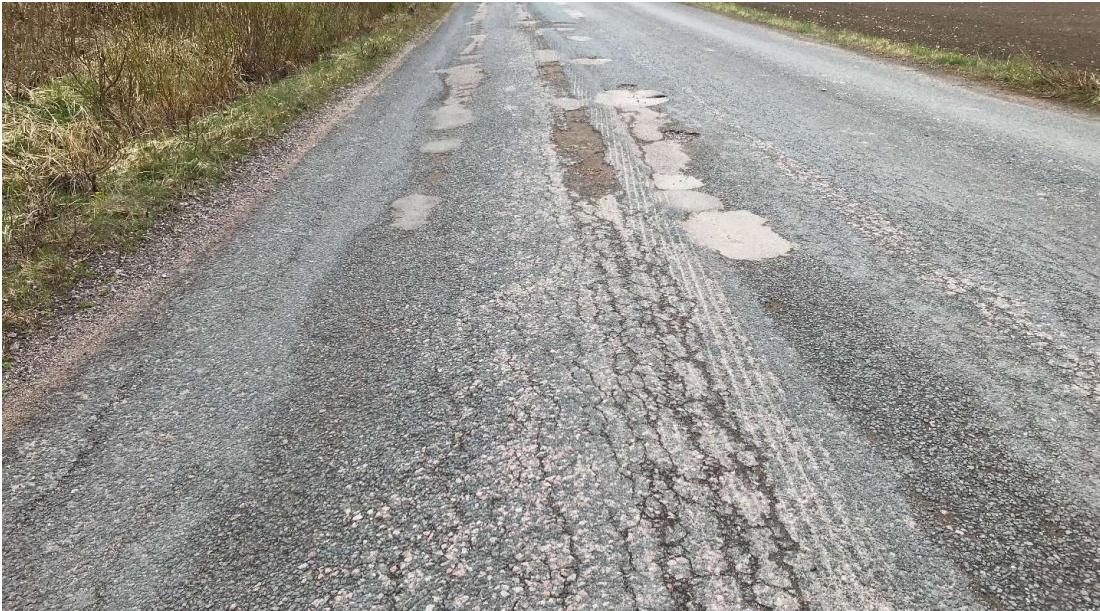
Vanhan SOP-tien tyypillisiä vaurioita ja korjauksia: Pt 11717 Maitoinen toukokuu 2019
