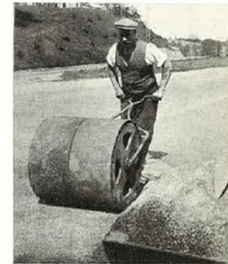
Kuva 33. Pintakäsittelyn jyräys kevyellä käsilyrällä, Mäntymäen luona Helsingissä v. 1932.
