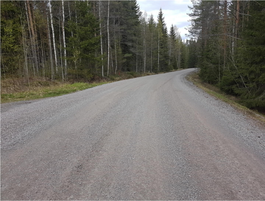
Kuva 4. Valkeejärvi 14307, Jämsä. Tie on kunnostettu soratieksi syksyllä 2018. Tien liikennemäärä: KVL: 60, KVL Raskas: 2. Kuvan pvm. 13.5.2019.
