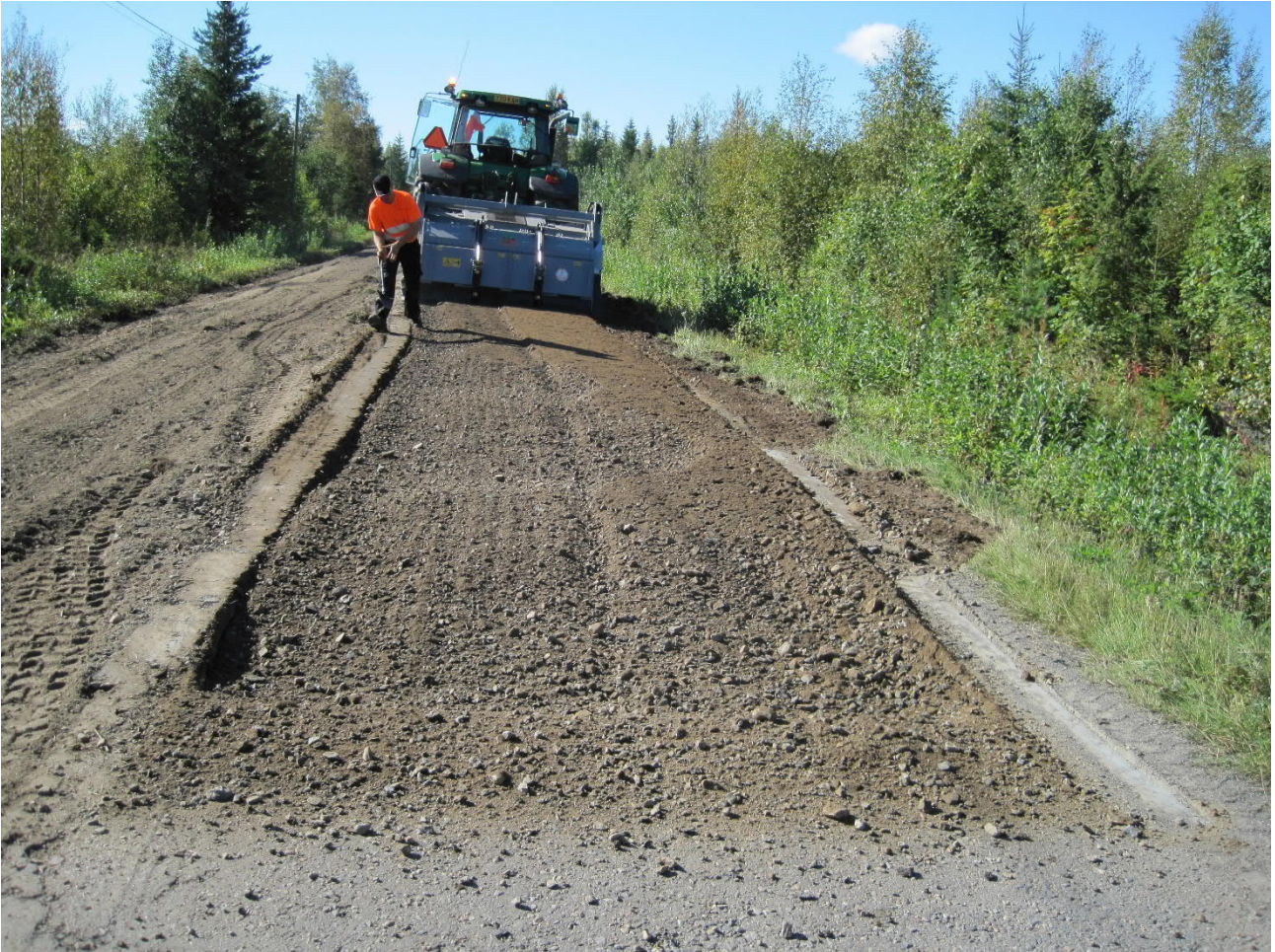
Kuva 3. Kivijyrsimen käyttöä muuttaessa päällystettyä tietä soratieksi.
