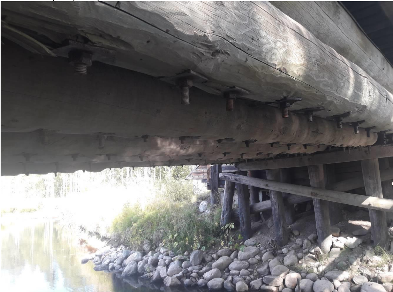
Kuva 9. Sillan kantavat vaarnapalkit, 5 kpl
