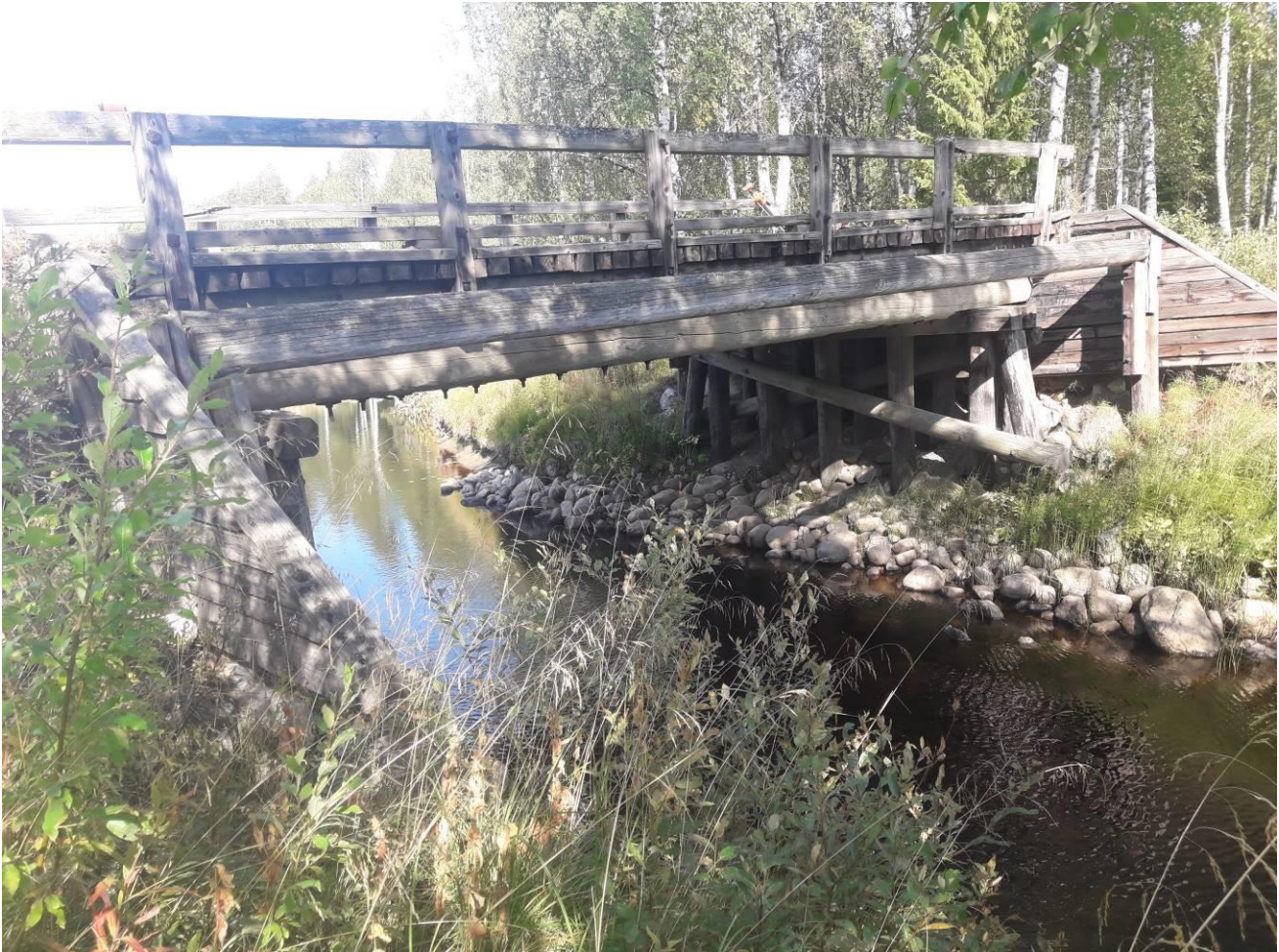
Kuva 6. Yleiskuva sillan vasemmalta puolelta
