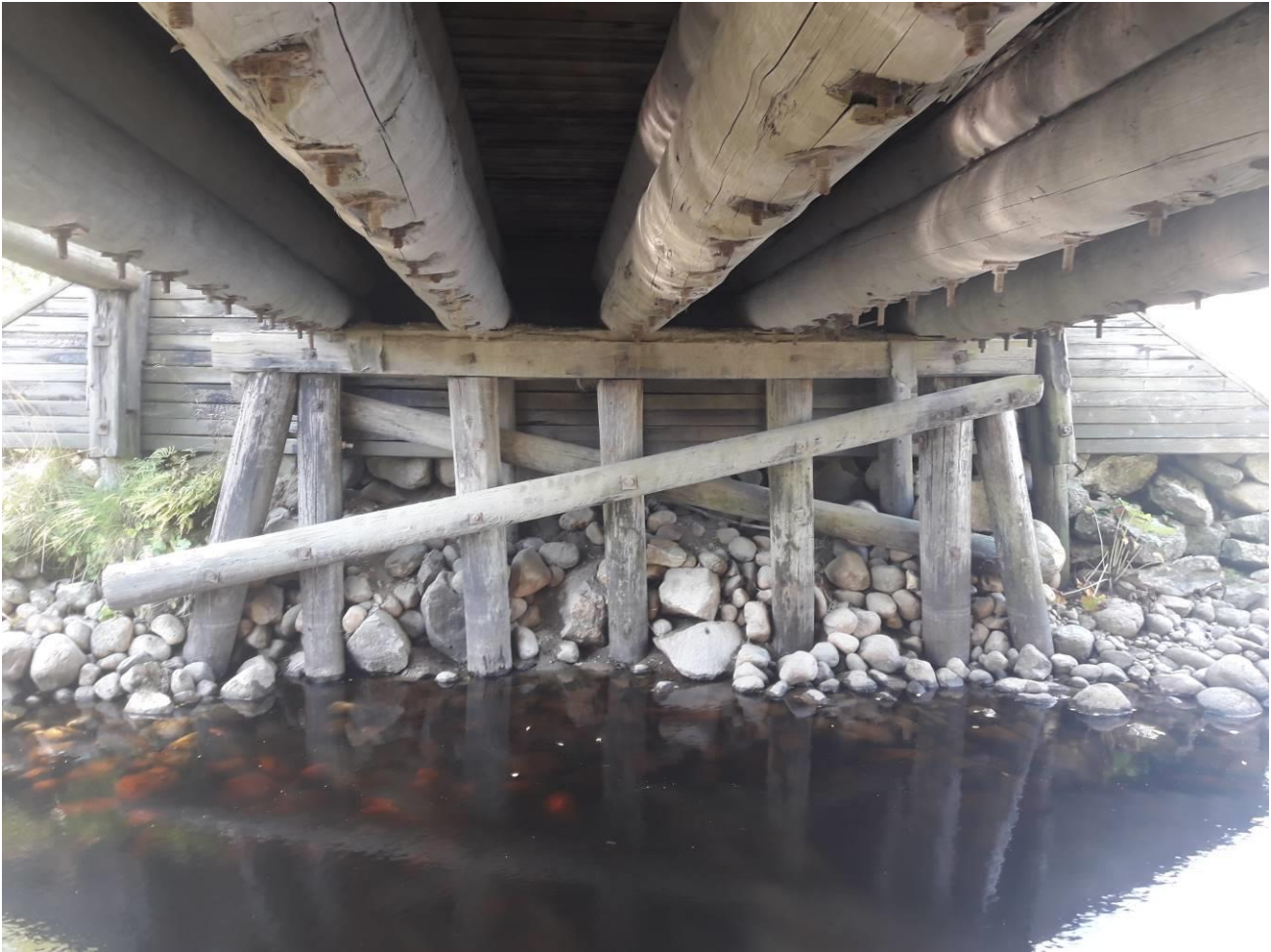
Kuva 8. Sillan peruspaalut ja maatuki 2
