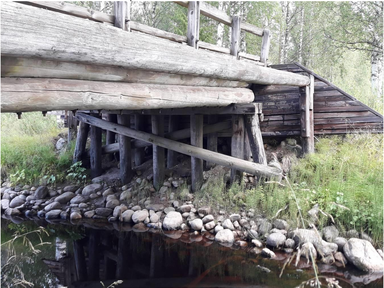
Kuva 7. Sillan peruspaalut ja maatuki 1
