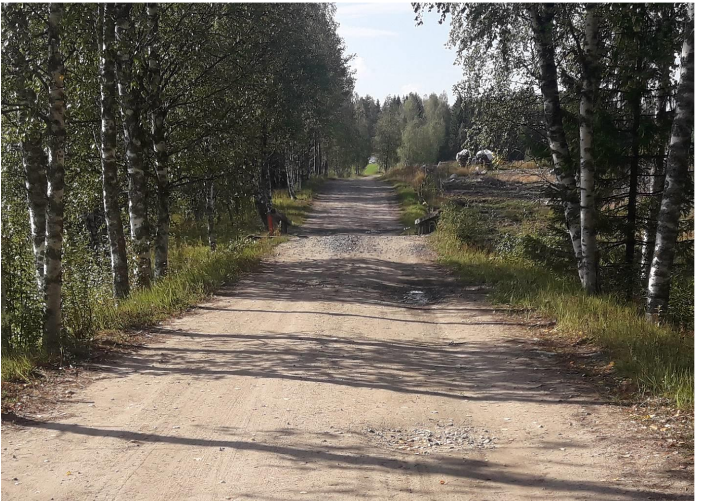
Kuva 4. Yleiskuva siltapaikasta Kurenkoskelle päin
