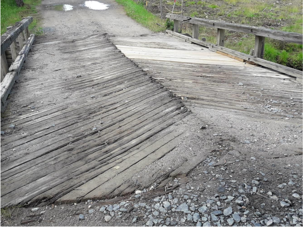
Kuva 10. Sillan kansi ja kaiteet
