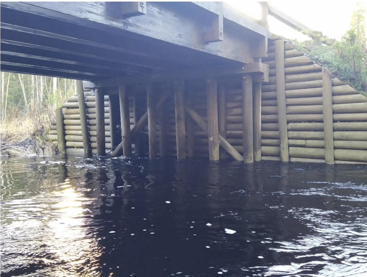
Kuva 6. Maatuki ja perustusrakenteet sekä palkistot
