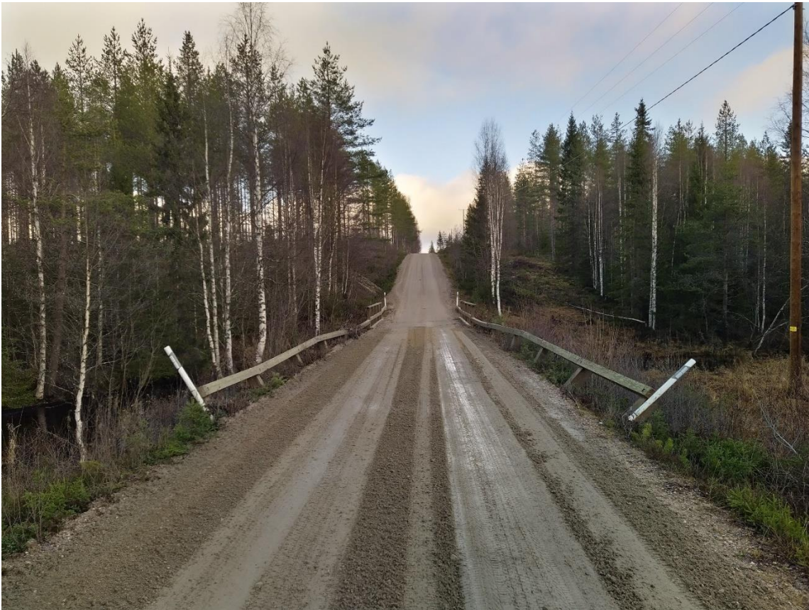
Kuva 3. Yleiskuva Papinahoon päin ja pengerkaiteet
