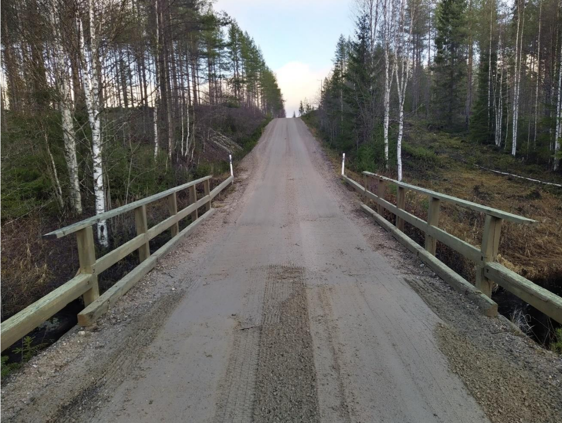
Kuva 5. Sillan kansi ja kaidarakenteet
