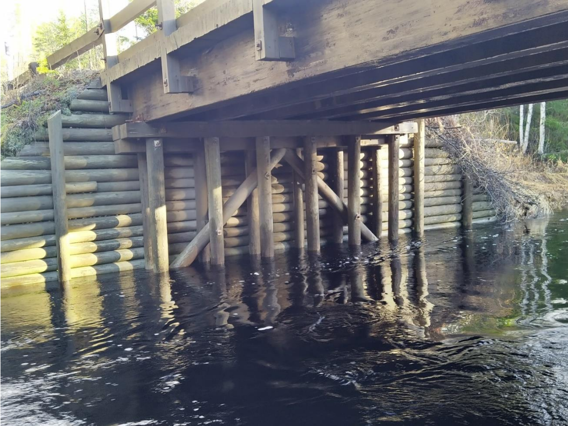
Kuva 7. Maatuki ja perustusrakenteet sekä palkistot
