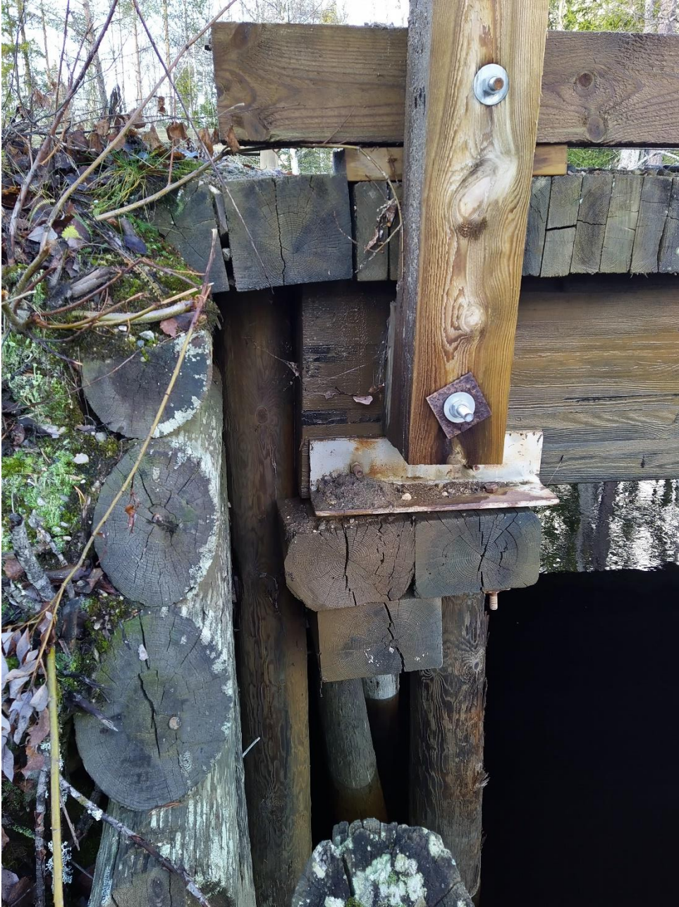
Kuva 9. Maatuki, laakeritaso ja kansirakenne
