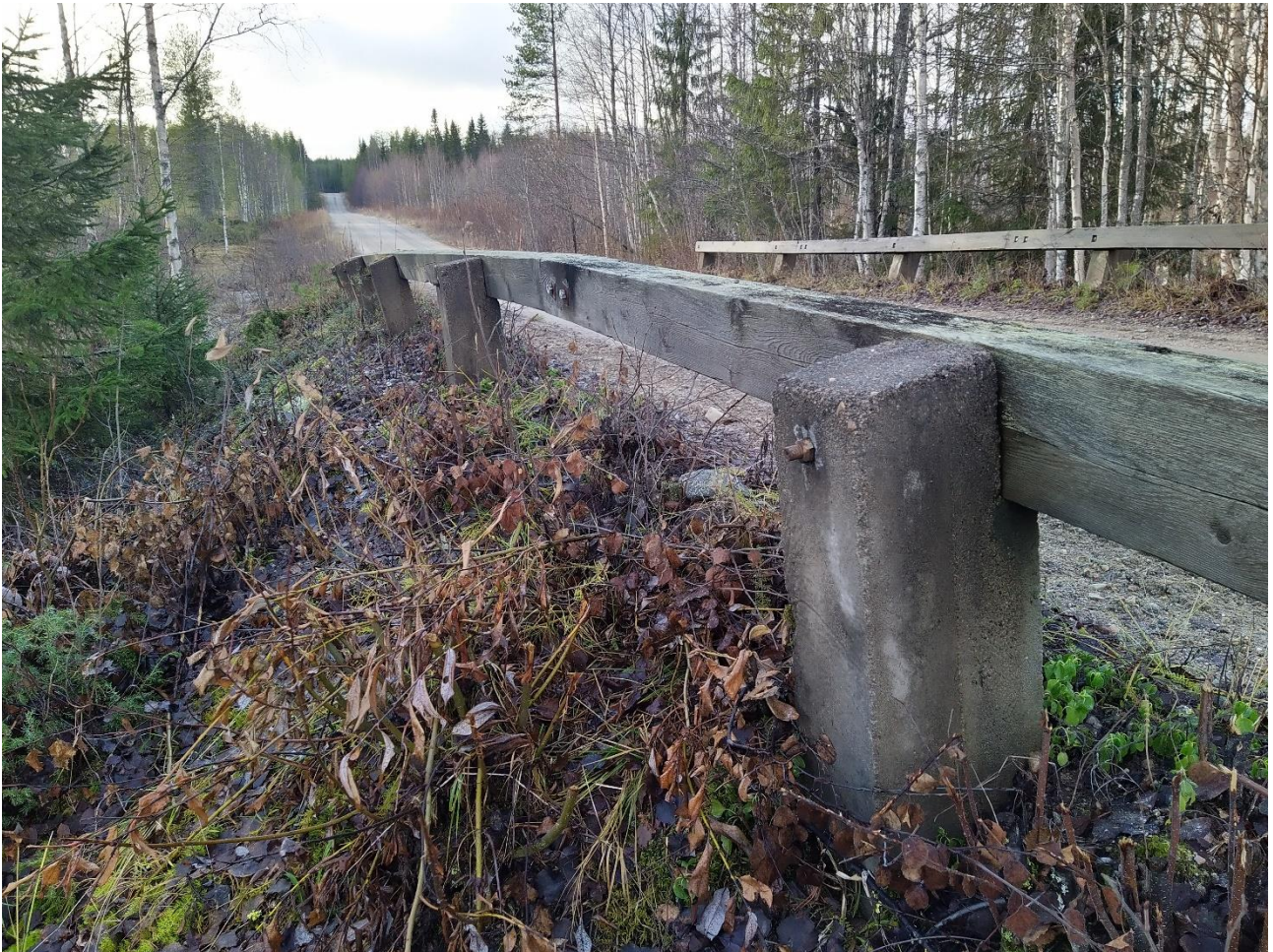
Kuva 10. Pengerkaiderakenne
