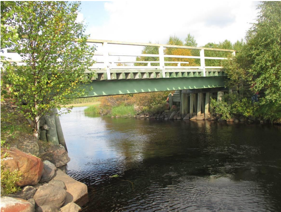
Kuva 5. Yleiskuva sillan vasemmalta puolelta.
