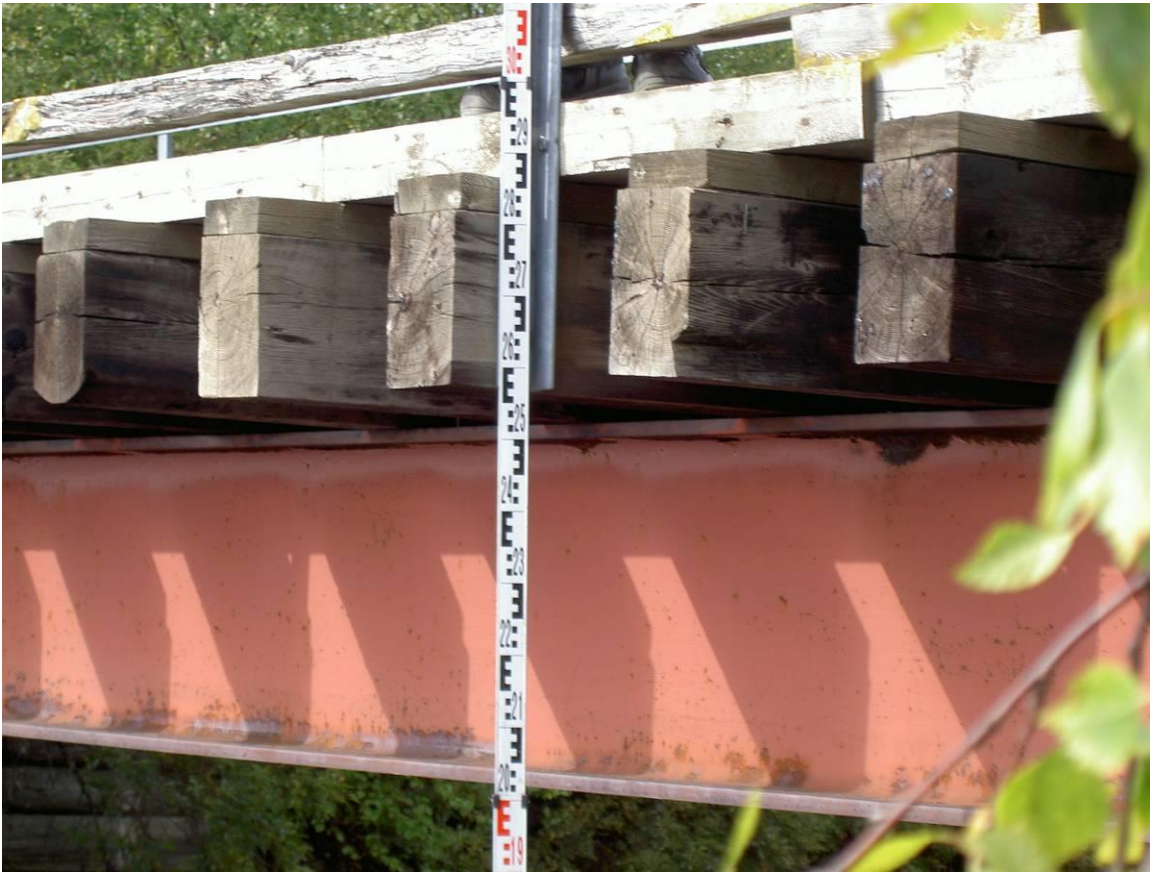
Kuva 24. Sillan päällys rakenne.
