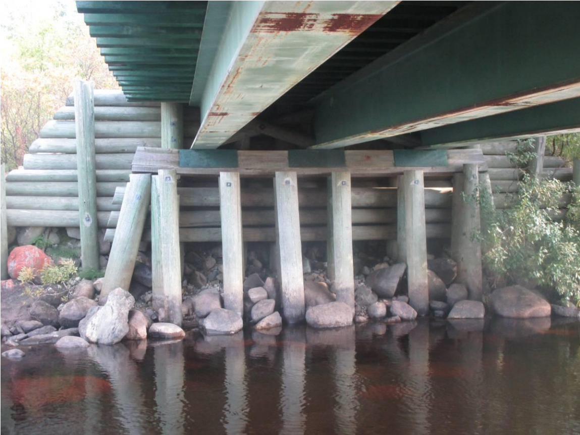
Kuva 18. Teräspalkkien korroosiovauriot.
