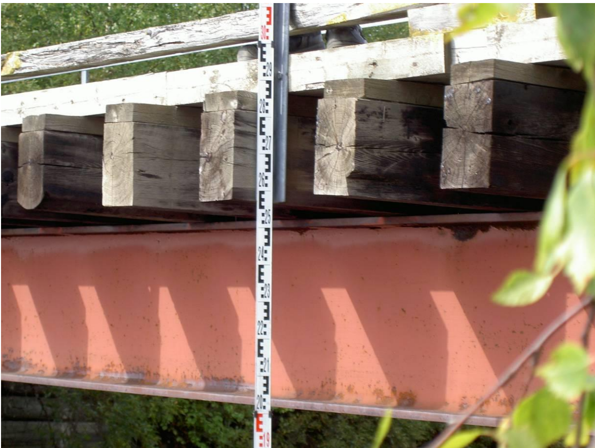
Kuva 35. Sillan korkeusaseman mittaaminen, latta vesipinnassa.
