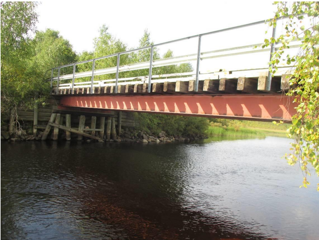
Kuva 21. Yleiskuva sillan vasemmalta puolelta.
