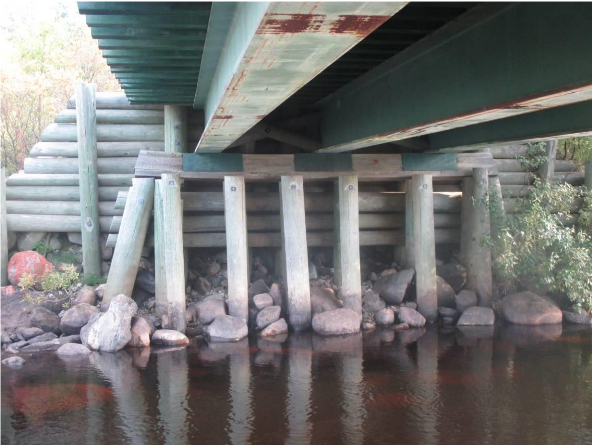
Kuva 16. Maatuki 1. , eroosiosvauriot.
