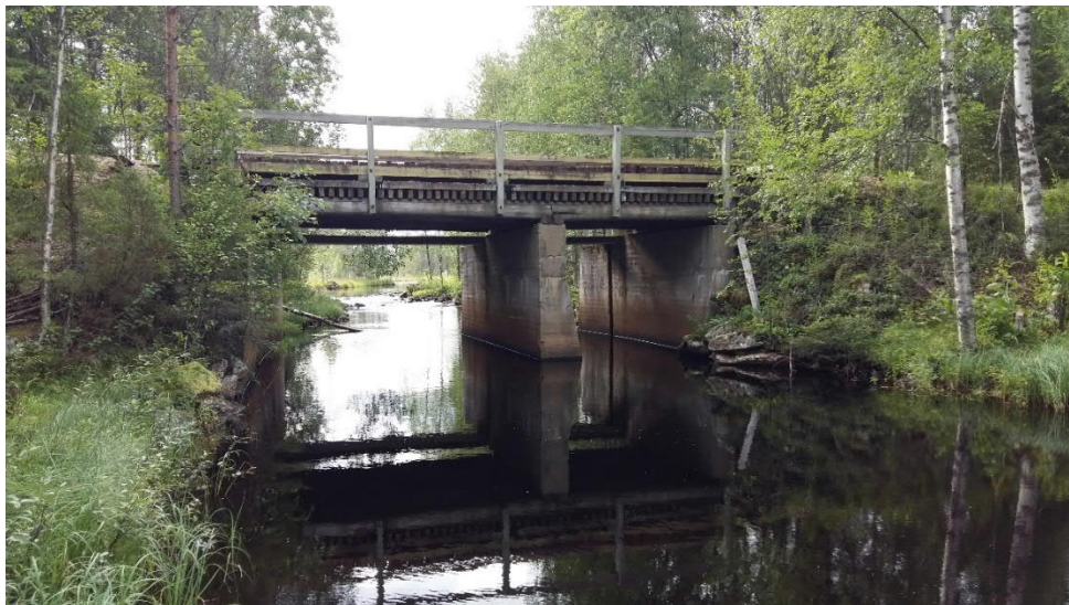
Kuva 7. Sillan läntinen maatuki T1 ja välituki T2
