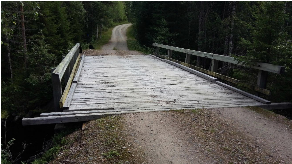
Kuva 2. Yleiskuva sillan länsipuolelta (inventointisuuntaan)
