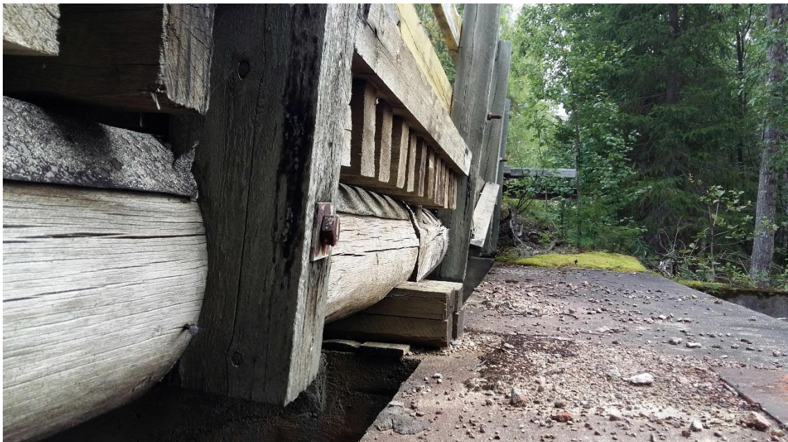
Kuva 12. Kaidarakenteissa on havaittavissa merkittävää lahoamista. Taustalla näkyy irronnut kaidetolppien välipuu.
