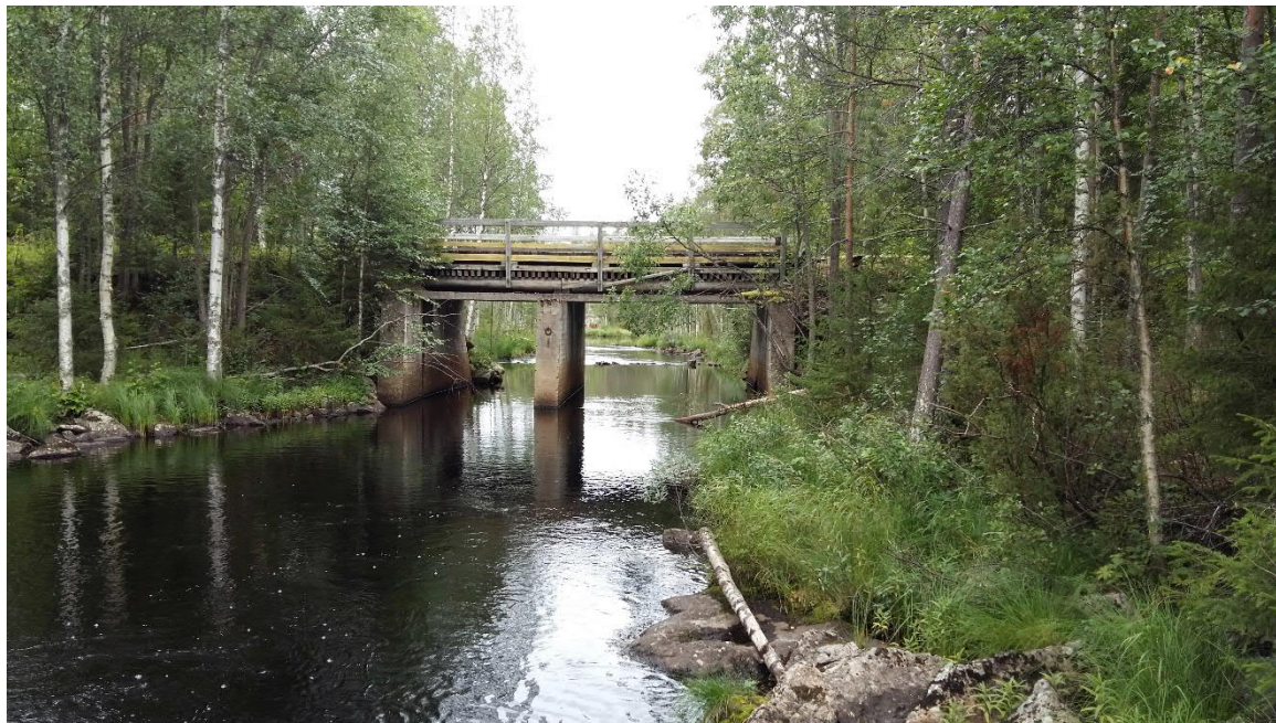
Kuva 4. Yleiskuva sillan eteläpuolelta (inventointisuuntaan nähden oikea puoli)
