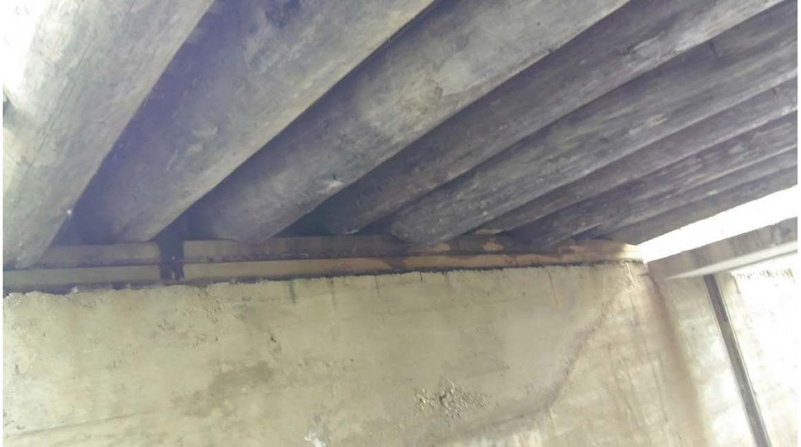
Kuva 8. Vanhat lahonneet tukkisiltarakenteen teräspalkkien alla (tukit 8kpl, D280, tukkien väli 600mm)
