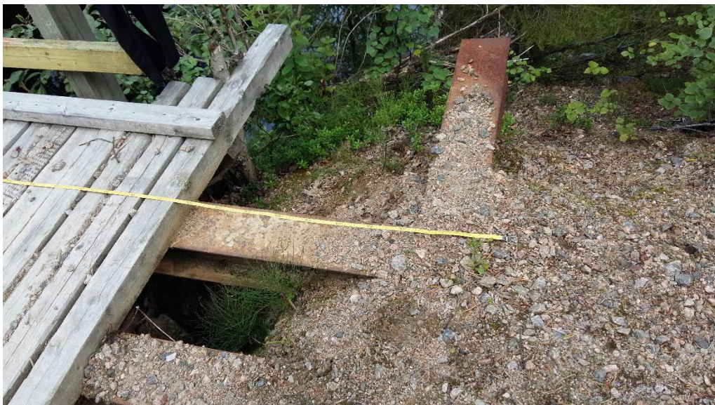
Kuva 9. Palkeissa merkittävää ruostumista. Pengertäytöt ovat valuneet palkkien välistä
