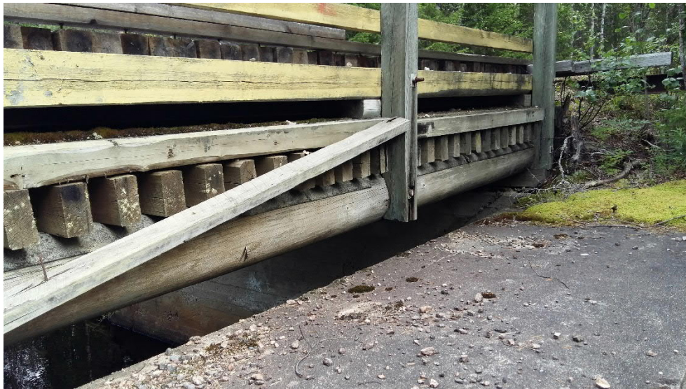
Kuva 6. Sillan itäinen maatuki T3 näkyy edessä olevan patorakenteen takaa
