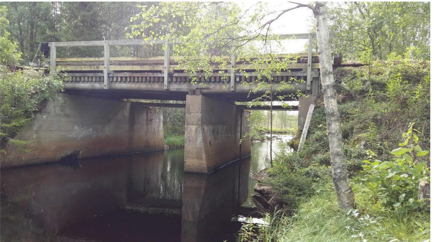
Kuva 4. Yleiskuva sillan pohjoispuolelta (inventointisuuntaan nähden vasen puoli)
