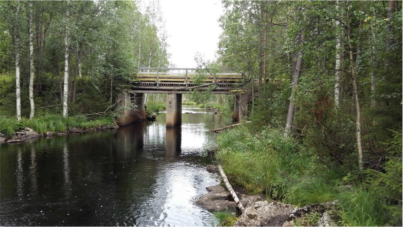
Kuva 3. Yleiskuva sillan eteläpuolelta (inventointisuuntaan nähden oikea puoli)
