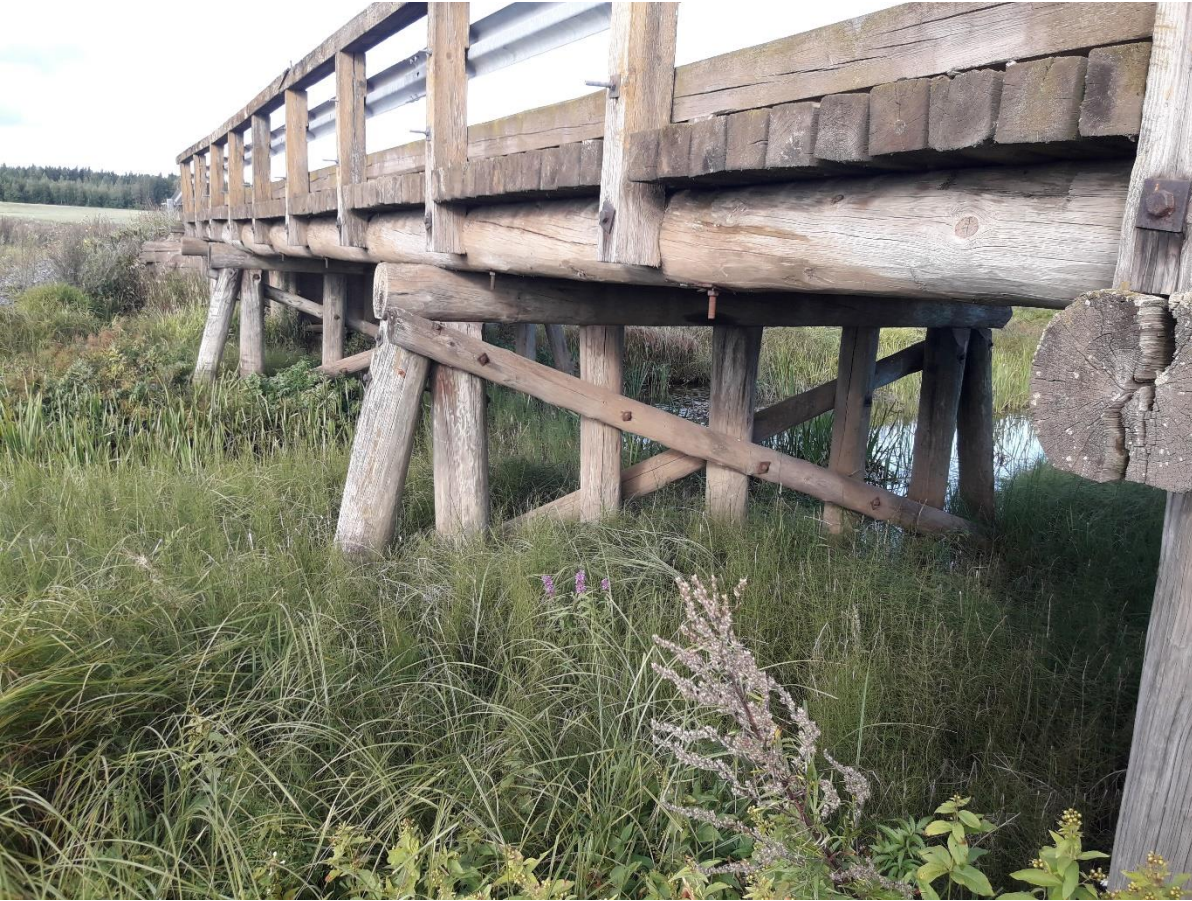
Kuva 5. Palkistot, peruspaalut ja niiden tuenta
