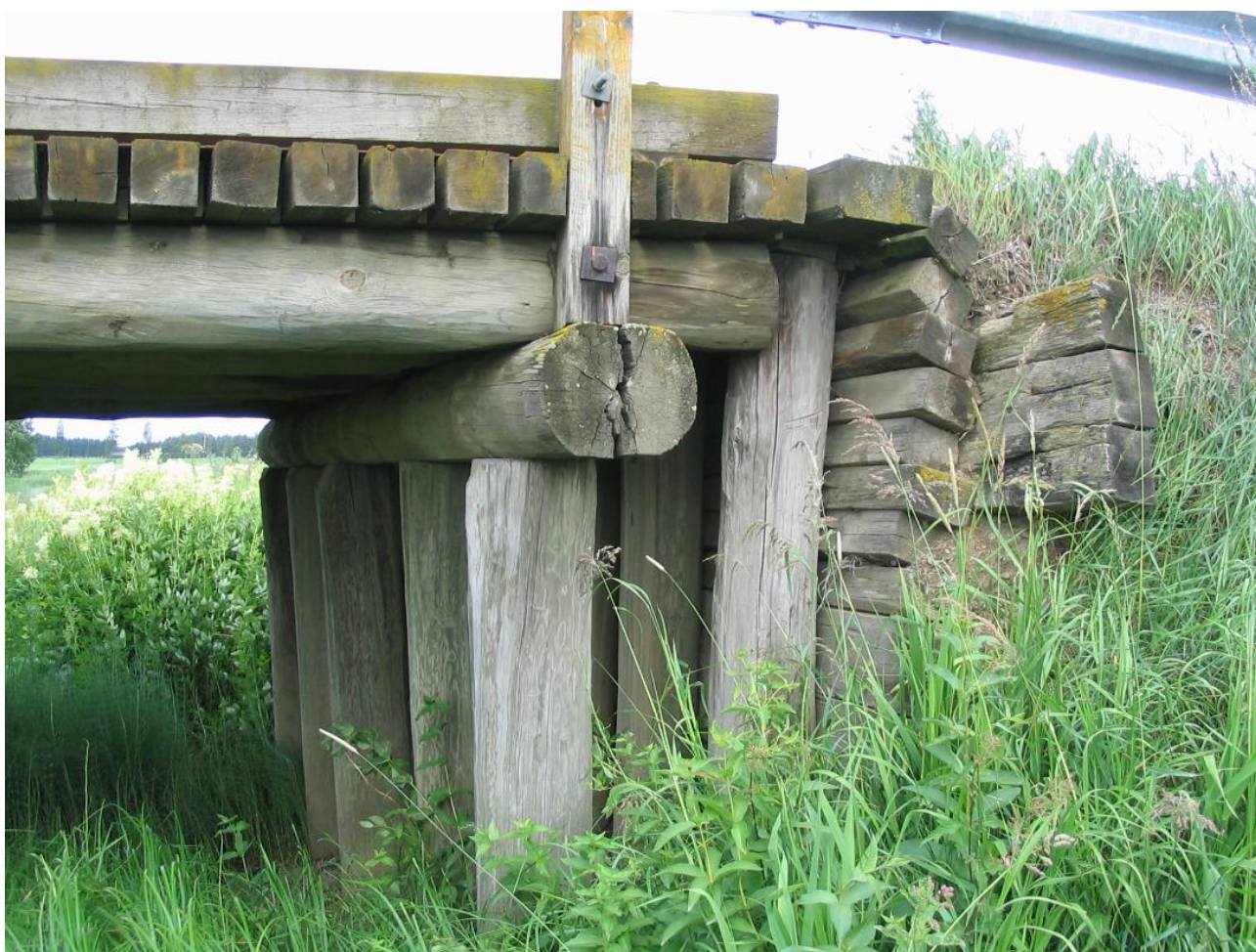
Kuva 4. Kannatinpaalut, laakeriparru ja maatukirakenteet
