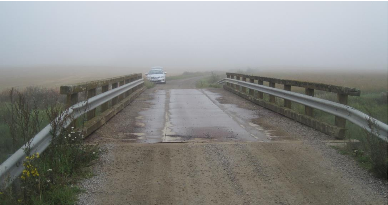
Kuva 7. Kansi ja kaidarakenteet
