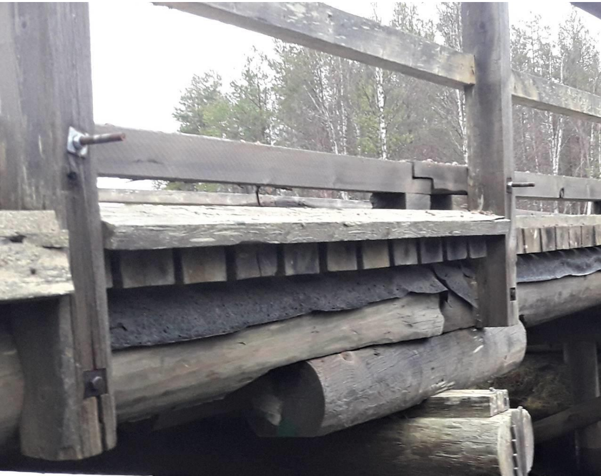
Kuva 12. Sillan kantava päällysrakenne
