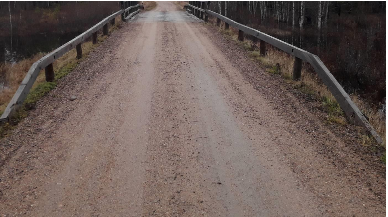
Kuva 14. Sillan pengerkaiteet
