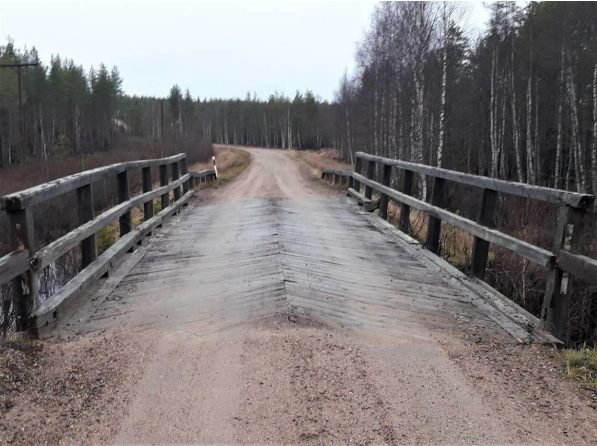
Kuva 13. Sillan kansi ja kaiteet
