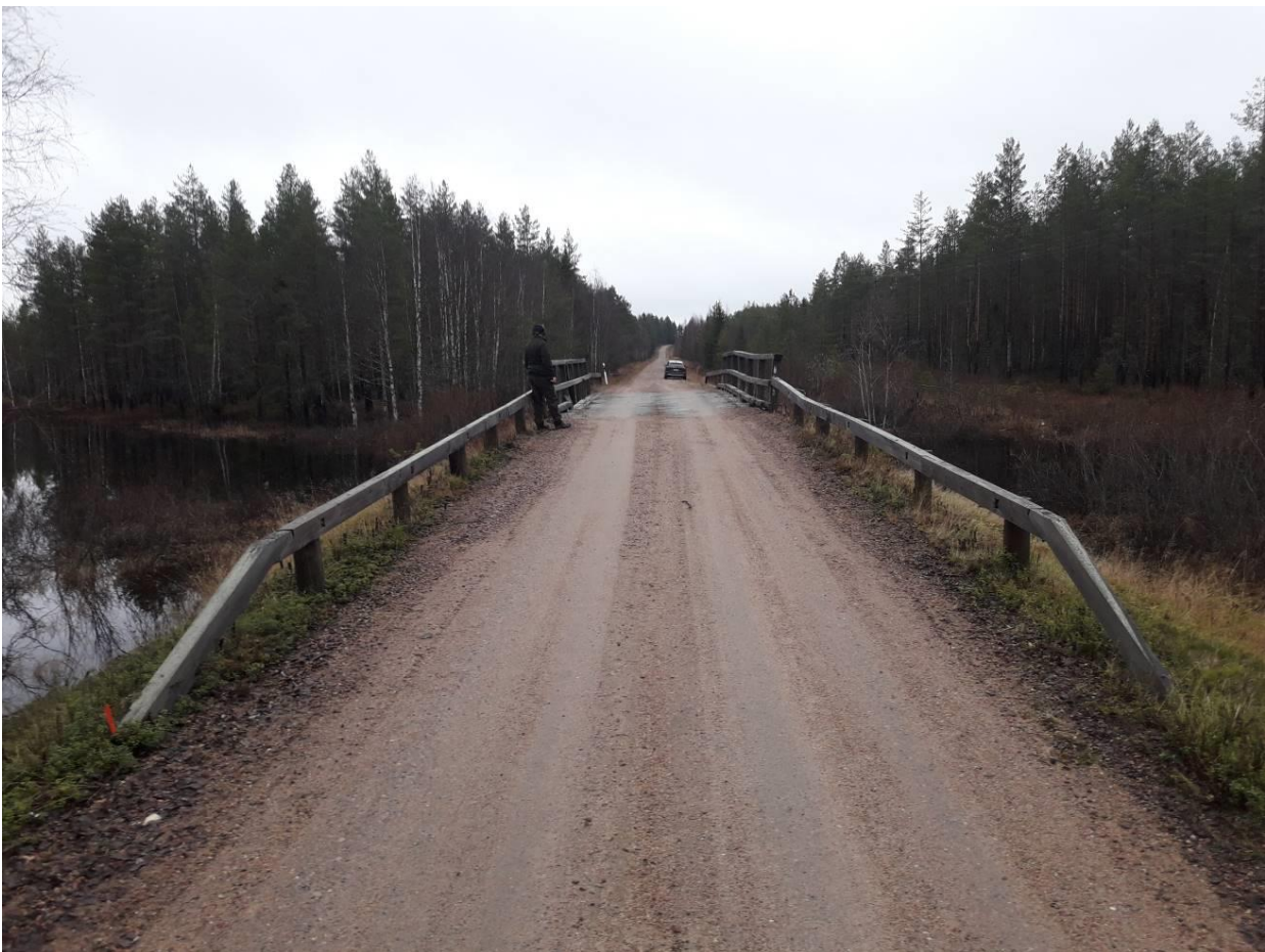
Kuva 4. Yleiskuva siltapaikasta Pelttarin suuntaan
