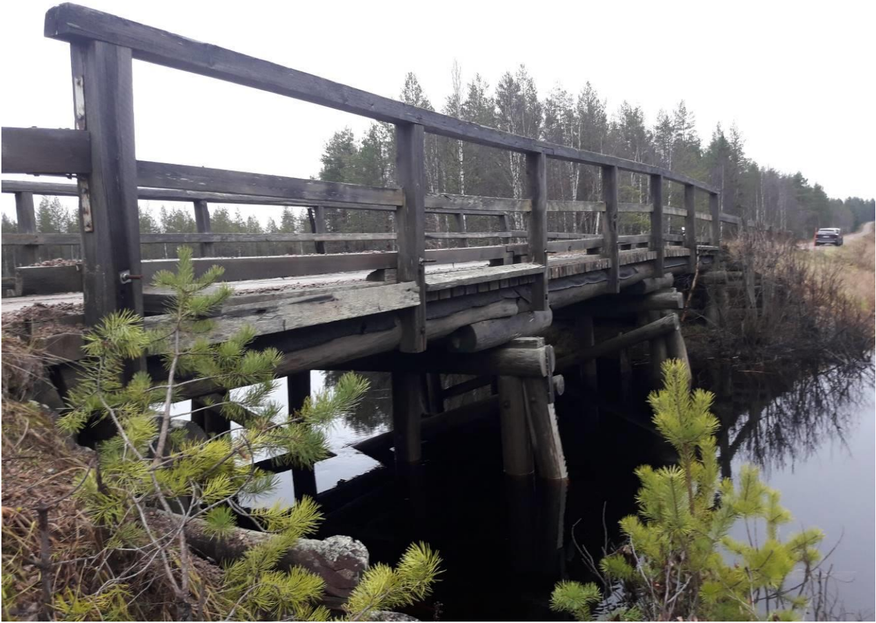
Kuva 5. Yleiskuva sillan oikealta puolelta
