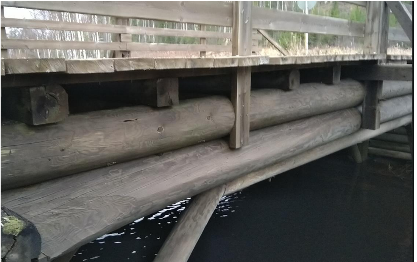
Kuva 12. palkisto ja kansirakenne
