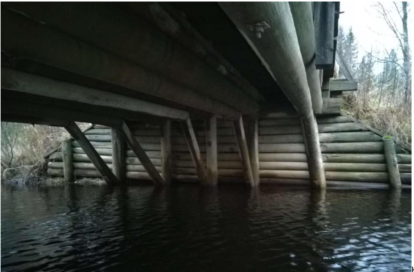
Kuva 6. Kannatinpalkit ja maatukirakenteet
