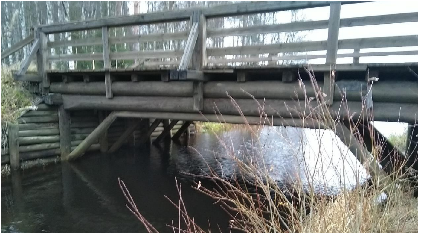
Kuva 11. Palkisto- ja kansirakenne
