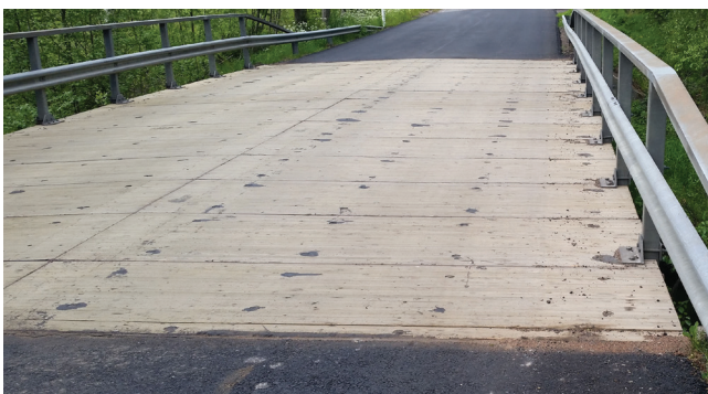
Kuva 3. Uusittu sillan liimapuuelementtikansi.
