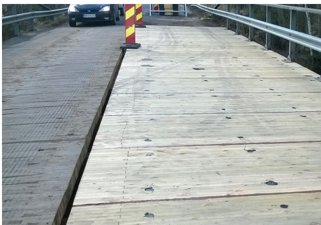
Kuva 16. Liimapuuelementtikannen uusimisen toteutus kahdessa vaiheessa puoli siltaa kerrallaan.
