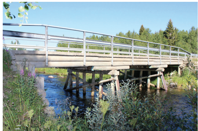
Kuva 6. Niskakosken silta, Kuusamo.
