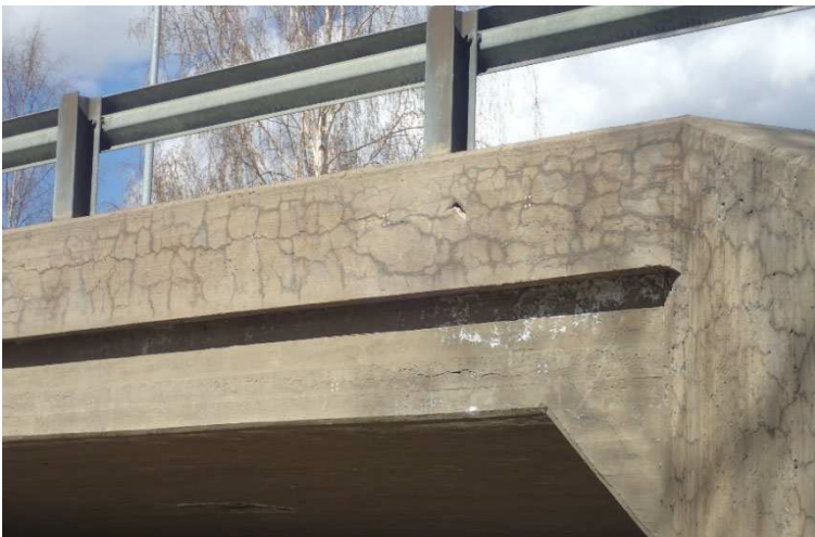
Kuva 6. Reunapalkeissa on otolliset edellytykset alkalikiviainesreaktiolle. Tyypillistä ruutumaista halkeilua ja mukana leveydeltään suurta halkeilua. AKR vauriokirjaus: Verkkohalkeilu VL2. Yksittäistä suurempaa halkeilua ei tarvitse kirjata erikseen halkeamana, jos sen voidaan katsoa kuuluva samaan vauriomekanismiin verkkohalkeilun kanssa (huomioitava mahdollinen teräskorroosion aiheuttama halkeilu). Huom. Reunapalkin ja laatan rajapinnassa näkyy erikseen kirjattava vesivuotovaurio. (Kuva: Ramboll Finland Oy)
