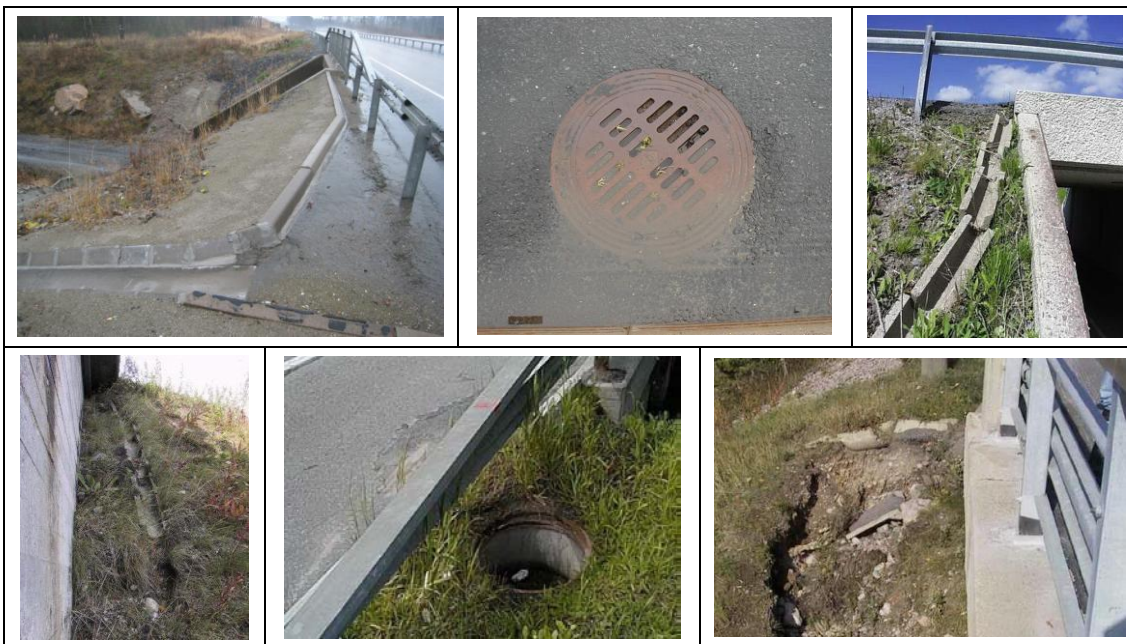
Kuva 20 Ylärivin vasen siltapaikka on kunnossa kuivatuslaitteiden osalta (A), mutta ylärivissä keskellä sadevesikaivo vaatii puhdistuksen (B). Ylärivissä oikealla samoin kuin alarivissä vasemmalla betonikouru vaatii kunnostuksen (C). Alarivissä keskellä tarvitaan niin ikään kunnostustoimenpiteitä (C), mutta oikealla joudutaan jo korjaustoimiin (D).
