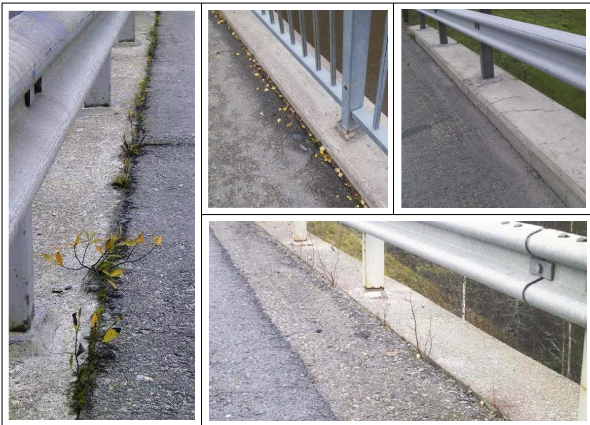
Kuva 8 Vasemmanpuoleisimman ja alimman sillan tapauksessa vuositarkastusmerkintä tulee C-sarakkeeseen, sillä saumat on kunnostettava. Ylhäällä keskellä riittää sauman puhdistus (B) ja ylhäällä oikealla merkintä tulee D-sarakkeeseen, sillä sauma puuttuu kokonaan.
