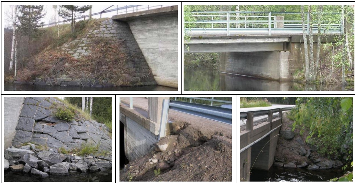
Kuva 22 Ylärivissä vasemmalla sillan keila pitää puhdistaa (B). Ylärivissä oikealla sillan keilat on puhdistettava vesakosta (B), mutta keilan puuston vuoksi vuositarkastusmerkintä tulee myös D-sarakkeeseen. Alarivissä vasemmalla on alle 2 m 2 :n purkautuma (C). Alarivissä keskellä on paha eroosiovaurio, joka vaarantaa liikenneturvallisuuden, joten välittömästi ilmoitus tilaajalle ja merkintä D-sarakkeeseen. Alarivin oikeanpuoleisimmassa sillassa keila vaatii puhdistuksen (B), jonka lisäksi keila on ehdotettava korjattavaksi ja puusto poistettavaksi (D).
