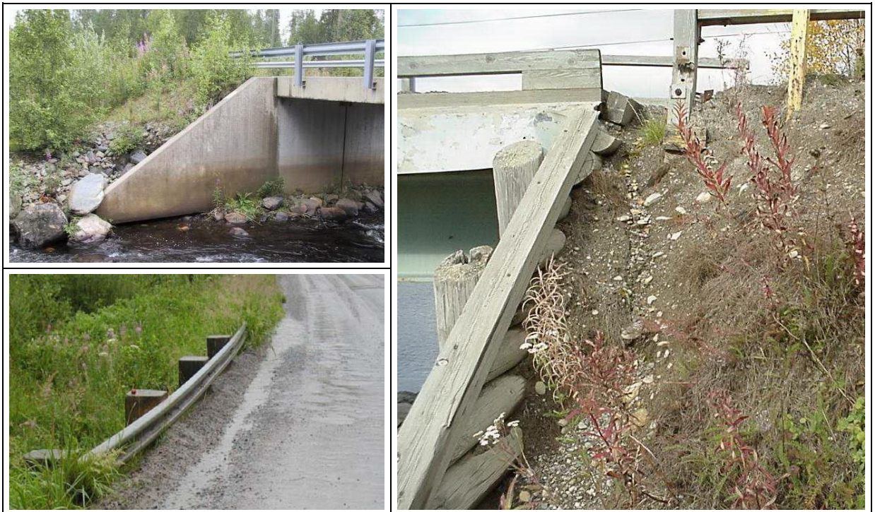
Kuva 23 Vasemmalla ylhäällä sillan tieluiska vaatii vesakon raivauksen (B) lisäksi korjausta (D). Vasemmalla alhaalla tieluiskan reunapalteet on poistettava (vuositarkastusmerkintä C-sarakkeeseen) ja oikeanpuoleisen sillan tieluiska on ehdotettava korjattavaksi (D-sarake).
