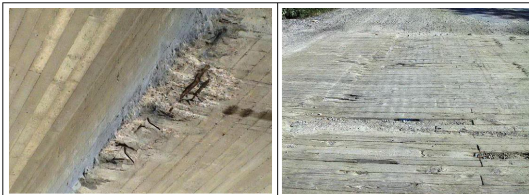
Kuva 4 Vuositarkastusmerkintä kuuluu D-sarakkeeseen vasemmanpuoleisen sillan osalta, sillä betonikannen alapinnassa on vakava törmäysvaurio. Oikeanpuoleisen sillan tapauksessa tulee vuositarkastuslomakkeeseen kaksi merkintää, B ja D: puukanella oleva hiekka on poistettava (B), mutta sen lisäksi kansi on niin pahasti kulunut, että asiasta on syytä raportoida tilaajalle (D).
