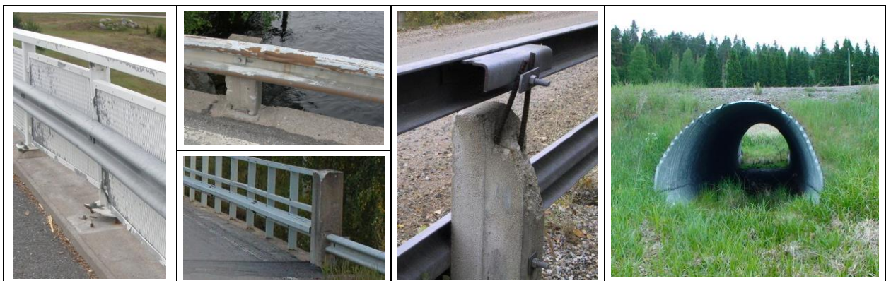
Kuva 11 Vasemmanpuoleisimman sillan tapauksessa vuositarkastusmerkintä kuuluu törmäysvaurion vuoksi C-sarakkeeseen. Kolmen keskimmäisen sillan tapauksessa vuositarkastusmerkintä tulee D-sarakkeeseen, perusteluina liian matala (ja huonokuntoinen) kaide, epäjatkuvuuskohta kaiteessa ukkopylvään kohdalla sekä vanha pikakorjaus, joka on syytä saattaa tilaajan tietoon. Oikeanpuoleisimmasta sillasta kaiteet puuttuvat kokonaan, mikä aiheuttaa vuositarkastusmerkinnän niin ikään D-sarakkeeseen.
