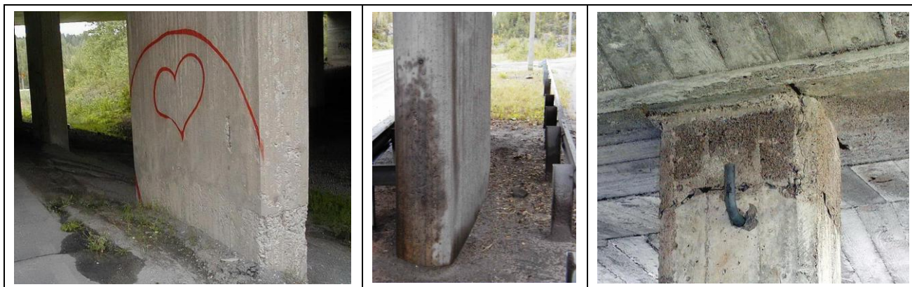
Kuva 2 Vuositarkastusmerkintä kuuluu B-sarakkeeseen kahden vasemmanpuoleisimman sillan välituen osalta. Vasemmanpuoleisimmassa tapauksessa irtonainen hiekka ja maa poistetaan välituen juurelta maanpinnan tasoon asti, keskimmaisessä pestään suolaroiskeet pois (vähintään 3 m korkeuteen saakka). Oikeanpuoleisessa kuvassa merkintä kuuluu sarakkeeseen D, sillä betoni on vaarallisesti lohkeillut välituen yläpäästä.
