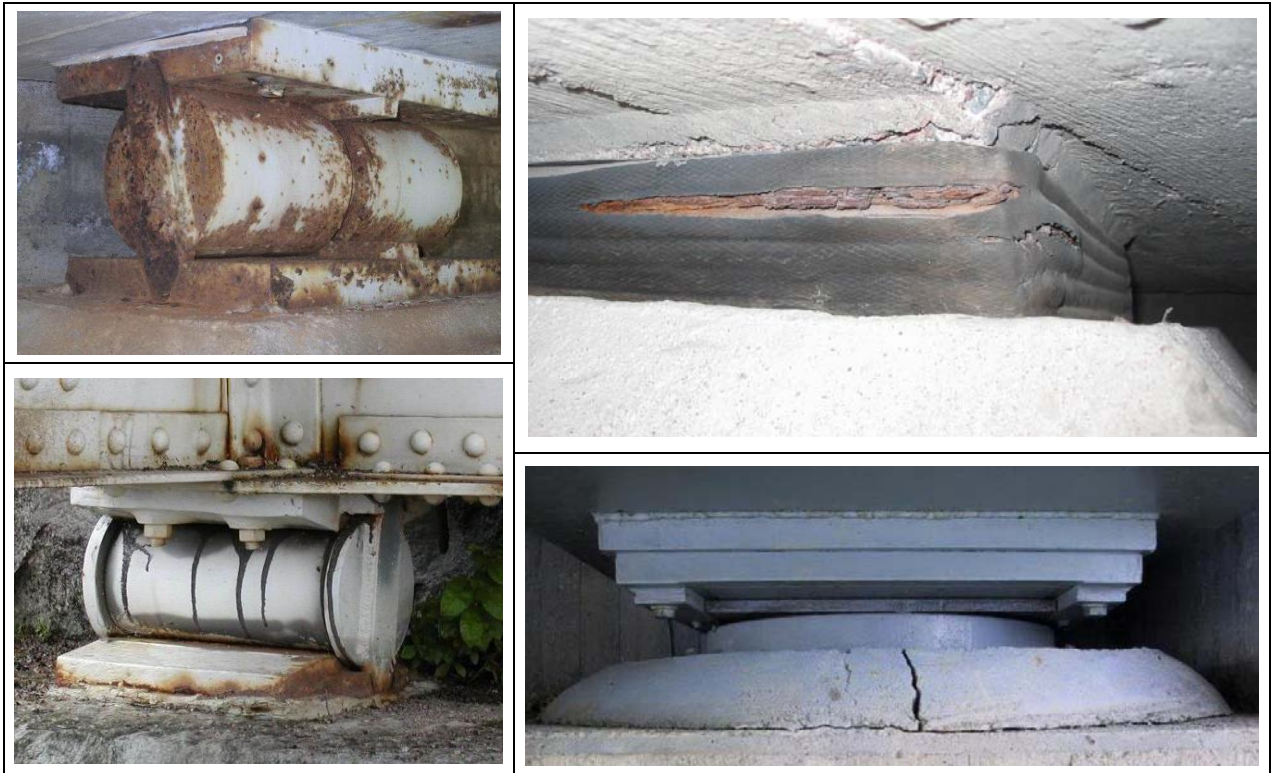
Kuva 13 Vasemmalla alhaalla rullalaakeri on hoidon suhteen kunnossa (A), mutta muiden laakereiden suhteen on ehdotettava korjausta (D), perusteluina voimakas ruostuminen, kumilamellien ulospuristuminen ja murtuminen sekä laakerikorokkeen halkeilu.
