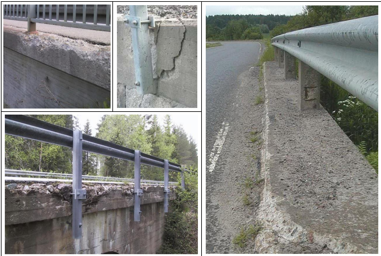
Kuva 6 Vasemmalla ylhäällä sillan reunapalkki on kunnossa hoidon alueurakoitsijan näkökulmasta (vaikka rapautumaa onkin) eli vuositarkastusmerkintä tulee A-sarakkeeseen. Oikeanpuoleisimman sillan reunapalkki kaipaa puhdistusta (merkintä B-sarakkeeseen). Ylhäällä keskellä ja alhaalla vasemmalla kaidteen kiinnitys on heikentynyt reunapalkin huonon kunnan vuoksi, joten vuositarkastusmerkintä laitetaan molemmissa tapauksissa D-sarakkeeseen.
