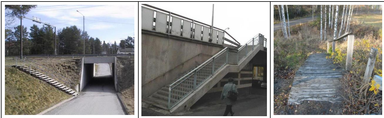
Kuva 24 Vasemmanpuoleisin ja keskimmäinen silta ovat portaiden osalta kunnossa, joten vuositarkastusmerkintä tulee A-sarakkeeseen. Oikeanpuoleisimman sillan portaat vaativat kunnostustoimenpiteitä kaiteen osalta, joten vuositarkastaja kirjaa havainnon C-sarakkeeseen.
