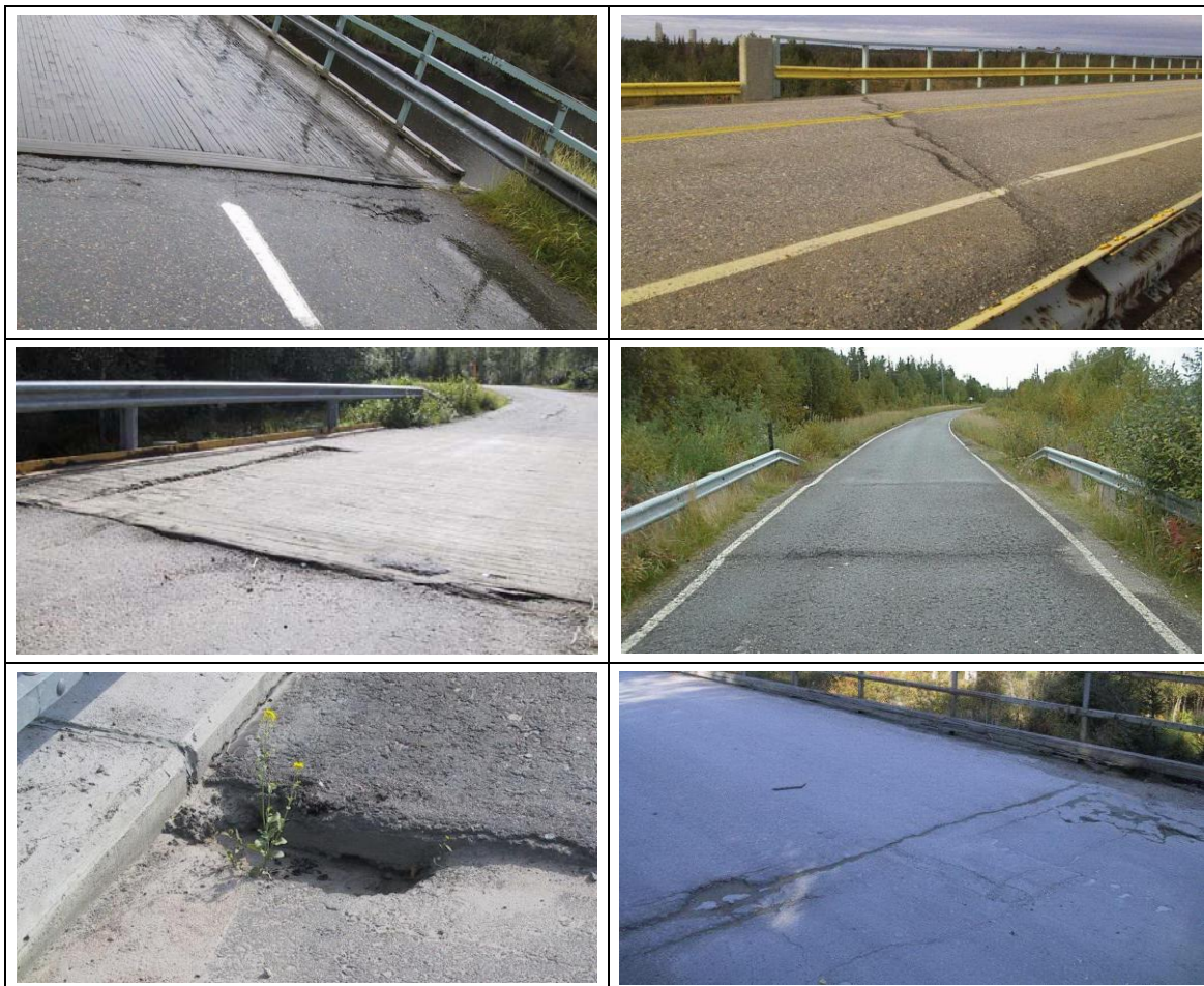
Kuva 10 Kaikkien siltojen tapauksessa sillan ja penkereen välisen kynnyksen poisto kuuluu hoitourakoitsijalle, eli vuositarkastusmerkintä tulee C-sarakkeeseen. Alarivissä oikeanpuoleisen sillan tapauksessa myös D-sarake voisi olla mahdollinen C-sarakkeen lisäksi, sillä sillan päätykohtaa on jouduttu paikkailemaan jo useampaan kertaan.
