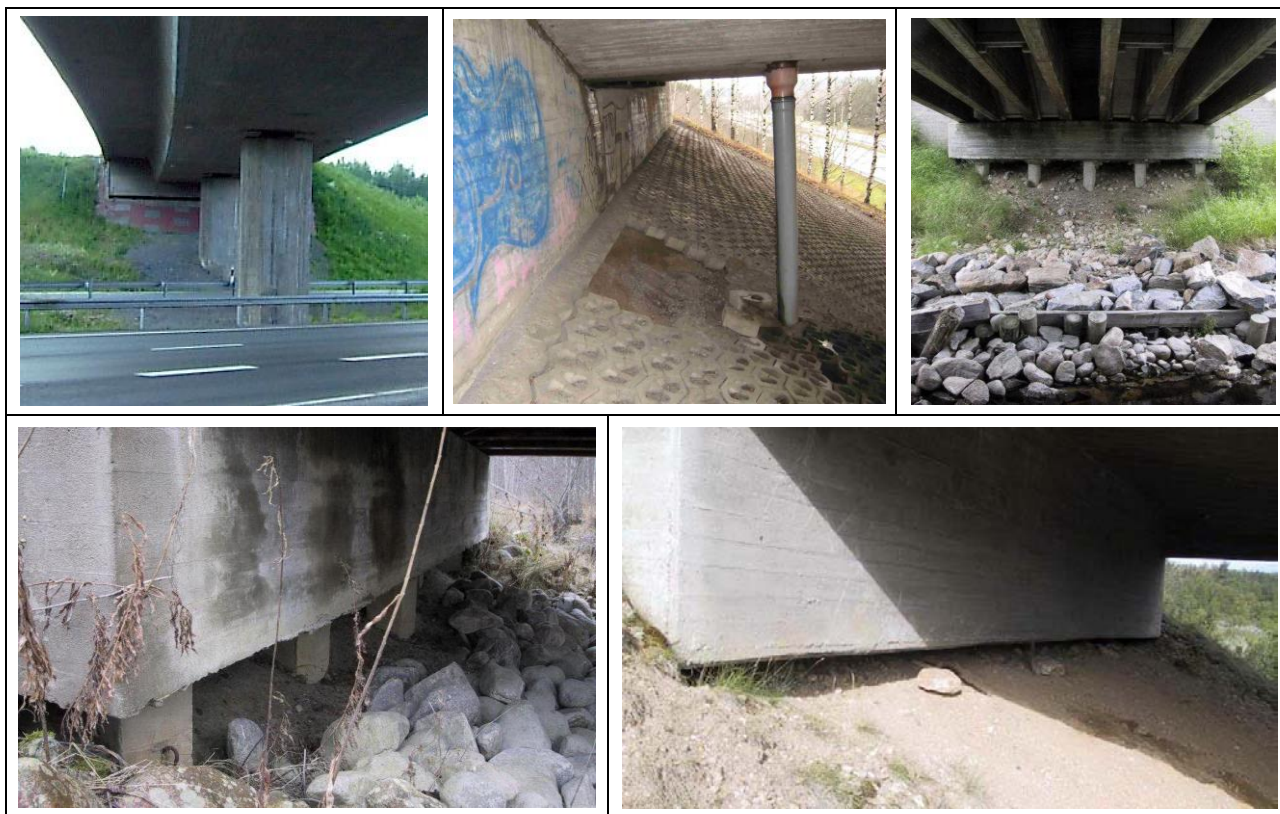
Kuva 21 Ylärivissä vasemmanpuoleisimman sillan tapauksessa etuluiska alkaa osoittaa jo heinittymisen merkkejä, joten B-sarake on oikea paikka vuositarkastusmerkinnälle, vaikka A-sarakekin saattaisi vielä yhden vuoden menetellä. Ylärivin keskimmaisessä sillassa etumuurin edessä on alle 2 m 2 :n kokoinen sidekiveypurkautuma, joten vuositarkastusmerkintä kuuluu C-sarakkeeseen. Ylärivin oikeanpuoleisin silta on selkeä D-tapaus etuluiskan osalta, samoin kuin molemmat alarivin sillat.
