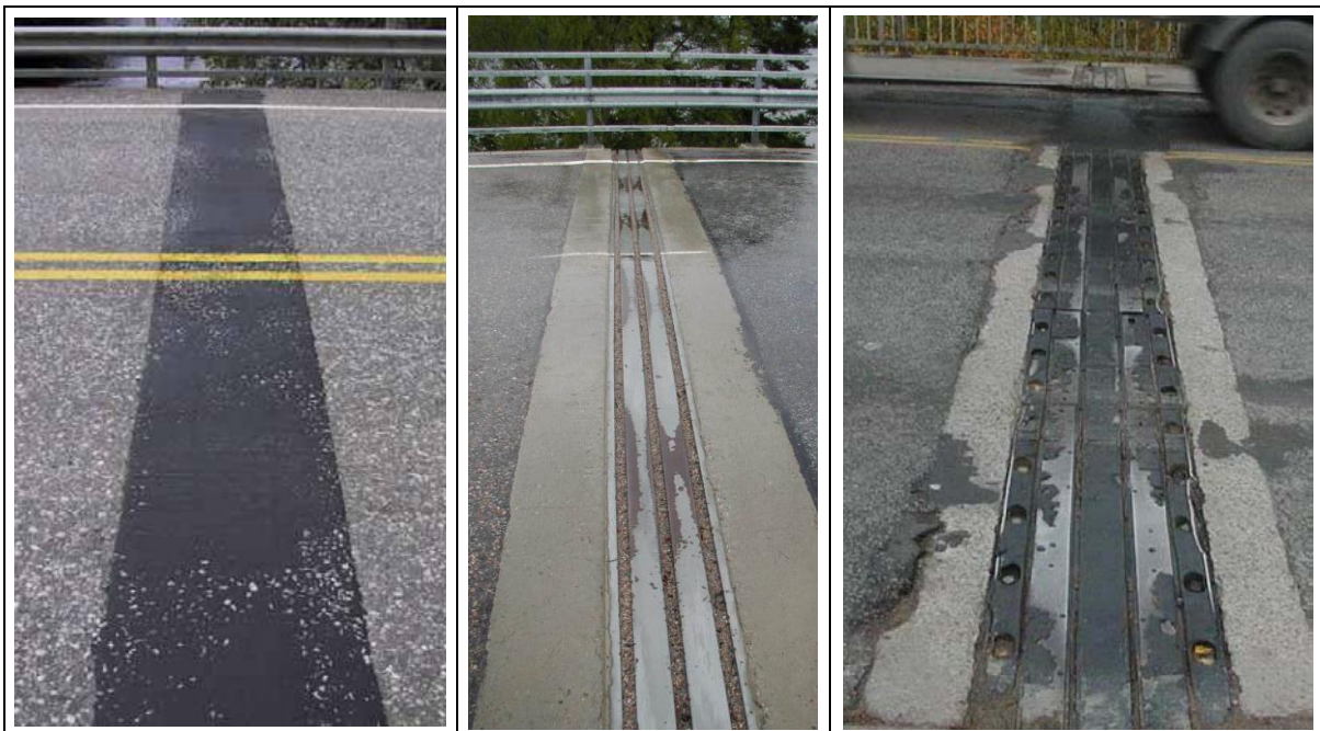
Kuva 12 Vasemmanpuoleisimmassa sillassa on massaliikuntasauga hyvässä kunnossa, joten vuositarkastusmerkintä tulee A-sarakkeeseen. Keskimmäisen sillan liikuntasaumalaite kaipaa puhdistusta, eli vuositarkastusmerkintä laitetaan B-sarakkeeseen. Oikeanpuoleisimman sillan liikuntasaumalaite on jo merkittävä korjausohjelmoitavaksi (D).
