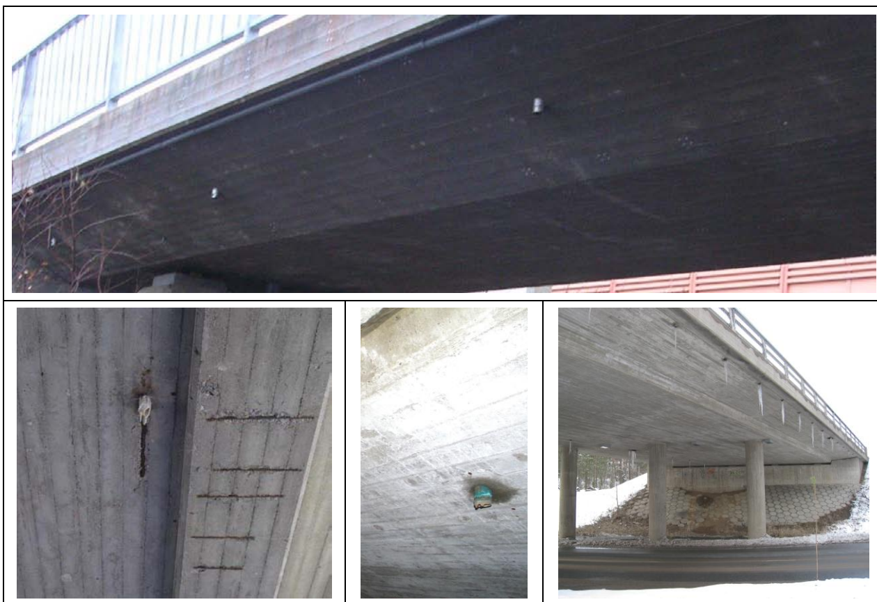
Kuva 15 Kuvan yläosan raittisillassa tippuputket ovat hyvässä kunnossa, joten vuositarkastusmerkintä tulee A-sarakkeeseen. Alarivissä kaikkien siltojen tippuputkien osalta vuositarkastusmerkintä laitetaan D-sarakkeeseen, sillä tippuputket ovat tukossa, niiden ympärillä on selkeää vesivuotoa tai niistä valuu vesi alittavalle tielle. Alarivin oikeanpuoleisimman sillan ilmiö (tippuputkista valuvan veden aiheuttamat jääpuikot) ei tietenkään toteudu vuositarkastuksen tekemisen aikoihin, mutta talvihoidon laatuvaatimusten mukaan liikennettä vaarantavat jääpuikot on poistettava. Nykyään tippuputkia ei enää ajoratojen kohdalle rakenneta, mutta vanhemmissa silloissa tilanne on valitettavan yleinen.
