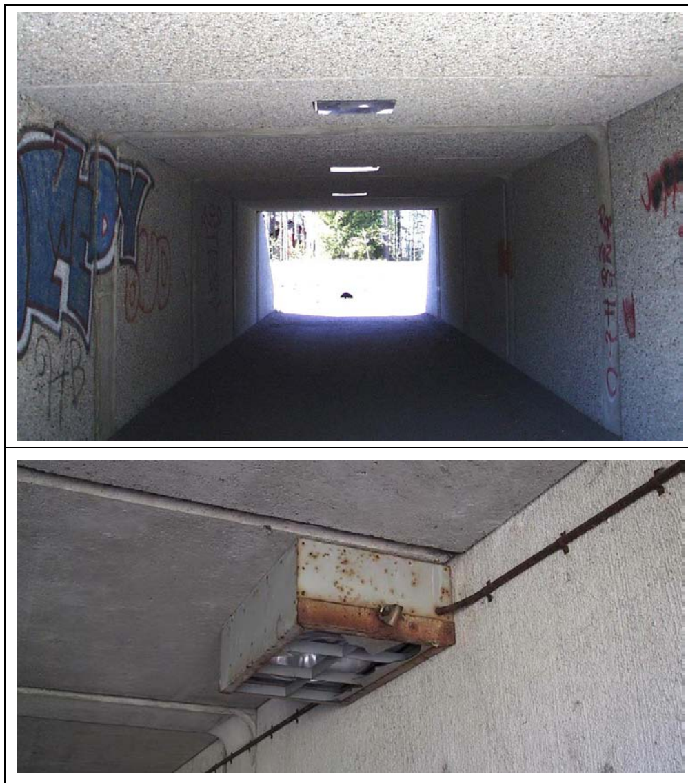
Kuva 17 Ylemmän alikulkukäytävän valaistuslaitteet ovat pääosin kunnossa (A), mutta alemman alikulkukäytävän valaistuslaitteiden kunto olisi syytä saattaa tilaajan tietoon (D), sillä lamput ovat rikki ja valaisimet pahasti ruosteessa.
