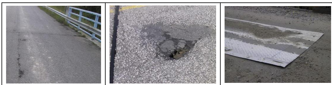
Kuva 5 Vuositarkastusmerkintä tulee C-sarakkeeseen kaikkien kolmen sillan osalta, sillä sillan päällysteessä olevien halkeamien, reikien, purkauksien ja liikennettä vaarantavien vaurioiden korjaukset kuuluvat hoitourakoitsijalle.
