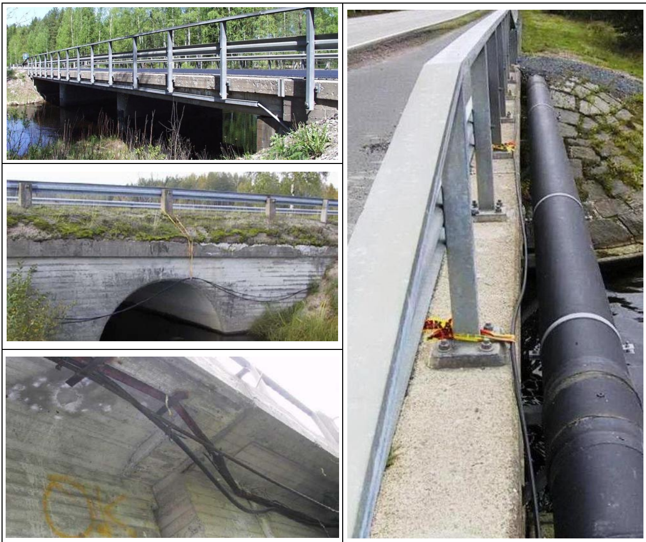
Kuva 18 Ylhäällä vasemmalla sillan johdot ja kaapelit ovat asianmukaisessa kunnossa (A), mutta muiden siltojen osalta ainakin osa siltoihin kiinnitetyistä johdoista tai kaapeleista repsottaa ja roikkuu, joten vuositarkastusmerkintä tulee D-sarakkeeseen.
