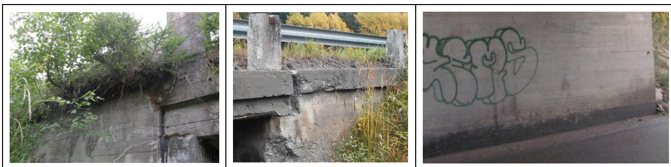
Kuva 1 Vuositarkastusmerkintä laitetaan B-sarakkeeseen kaikkien siltojen maatukien osalta, sillä maatuissa tai niiden päällä on kasvillisuutta ja maa-ainesta (vasen ja keskimäinen silta) ja maatuet tulee niiltä osin puhdistaa, tai kyseessä on suolasumun rasittama risteyssillan maatuki (oikea silta), joka on selkeästi likainen ja puhdistamatta alaosastaan. Huom. Keskimäisen sillan maatuen rapautuminen on pitkän ajan tulosta ja täten jo ylläpidon tiedossa yleistarkastusten ansiosta, joten D-sarakemerkintä ei ole tarpeen, vaikka maatuki huonokuntoiselta näyttääkin.
