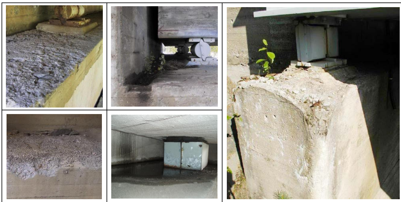
Kuva 3 Yläriivin vasemmanpuoleisen sillan laakeritason vuositarkastusmerkintä kuuluu sarakkeeseen A (kaikki on kunnossa hoitourakoitsijan näkökulmasta, vaikka laakeritasolla onkin havaittavissa rapautumista). Ylhäällä keskellä ja alarivin vasemmanpuoleisen laakeritason tapauksissa vuositarkastusmerkintä kuuluu sarakkeeseen B (urakoitsijan on puhdistettava laakeritasolta kasvillisuus ja karkea irtoaines varoen laakereiden likaantumista). Alhaalla keskellä vuositarkastaja laittaa merkinnän D-sarakkeeseen laakeritasolla olevan vesilammikon vuoksi. Oikeanpuoleisimman sillan tapauksessa vuositarkastuslomakkeeseen tulee kaksi merkintää, nimittäin sarakkeisiin B ja D. Laakeritasolta on poistettava kasvillisuus varoen laakereiden likaantumista, mutta sen lisäksi kyseinen tarkastuskohde on ehdotettava korjattavaksi: laakeritason rapautuminen on jo edennyt niin pitkälle, että asia on hyvä saattaa tilaajan tietoon vuositarkastuksen yhteenvetoraportin myötä.
