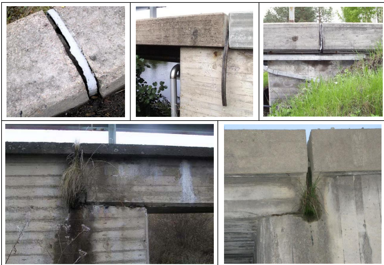
Kuva 7 Yläarvin siltoja tarkastettaessa vuositarkastusmerkintä laitetaan C-sarakkeeseen ja urakoitsija kunnostaa säamat 30.9. mennessä. Alarivin siltojen tapauksissa vuositarkastuslomakkeeseen tulee kaksi merkintää, B ja D. Rakennusvaiheessa avoimeksi jätetyt reunapalkin liikuntasäamat (D) ovat täynnä maata, irtoainesta ja kasvillisuutta, joka pitää poistaa ja säamat puhdistaa (B).
