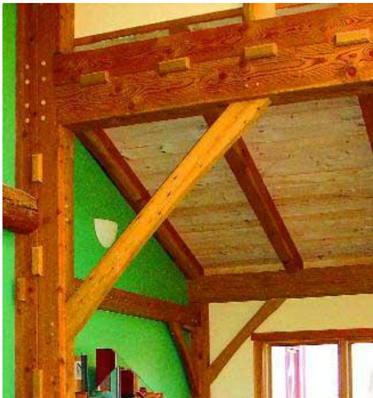
KUVA 11. Vaarnapilari. Vaarnapalikat asennettu vaakaan, jolloin pilari pystyy ottamaan vastaan vaakavoimia molemmista suunnista (Brungraber & Miller 2009).
