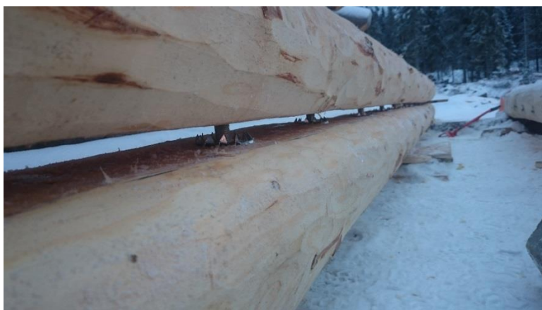
KUVA 33. Hammaslevyllisen vaarnapalkin kokoaminen (Eskelinen 2015)
