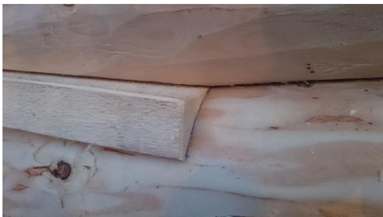
KUVA 30. Hyvin pureutuva liitos loveuksen pystypinnoilla, mihin puristusvoimat kohdistuvat (Eskelinen 2015).
