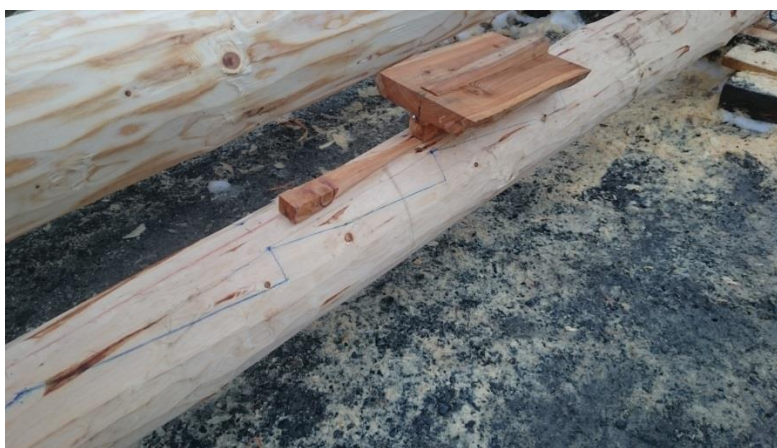
KUVA 23. Hammastuksen piirto alempaan puuhun (Eskelinen 2015)
