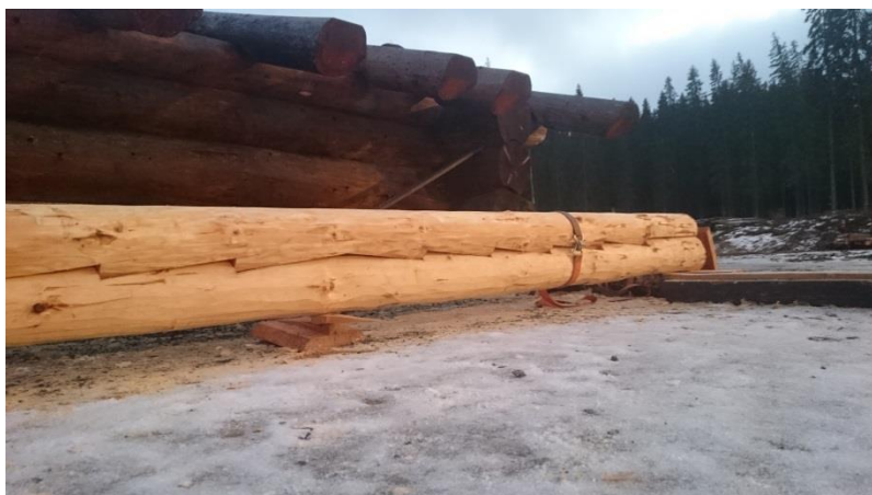
KUVA 26. Porausta ja kierretankoja vaille valmis hammastettu vaarnapalkki (Eskelinen 2015)
