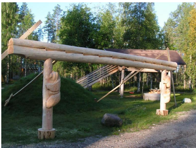
KUVA 19. Hammastettuvaarnapalkki luonnonpyöreässä puussa uniikeilla pilareilla (Alppisalvos Oy 2015)
