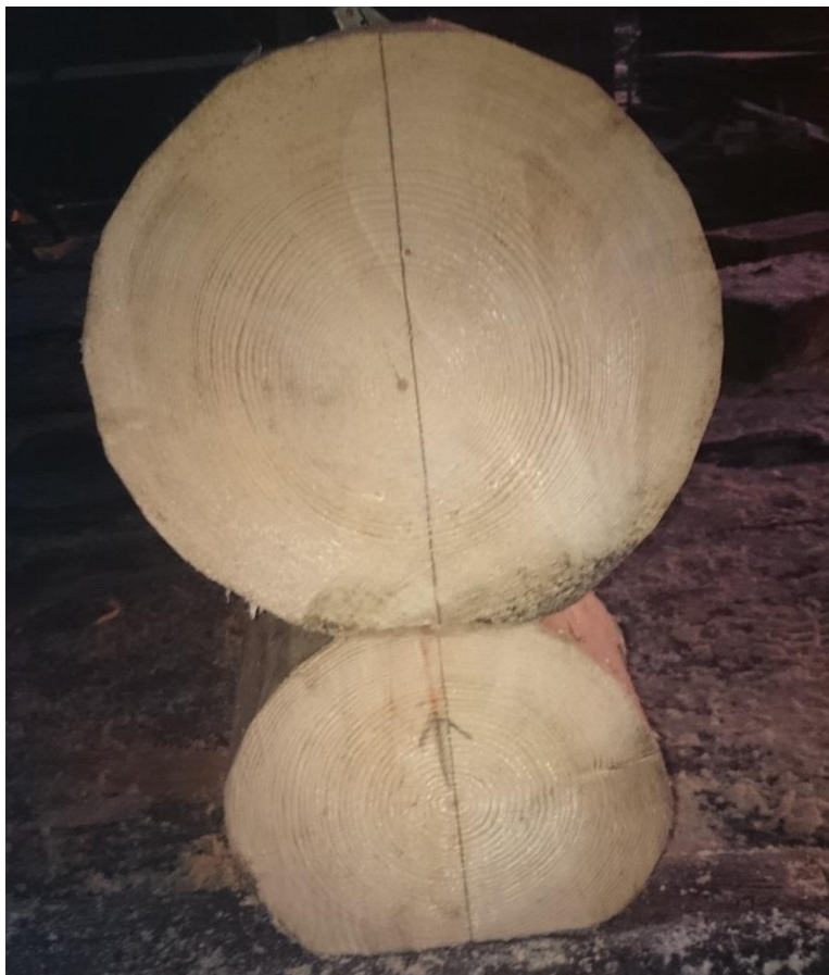
KUVA 34. Vaarnapalkki onnistuttu asentamaan kohdalleen (Eskelinen 2015)
