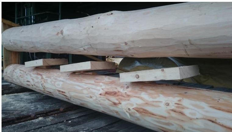
KUVA 27. Palikat asennettuna ja piirrettyä (Eskelinen 2015)
