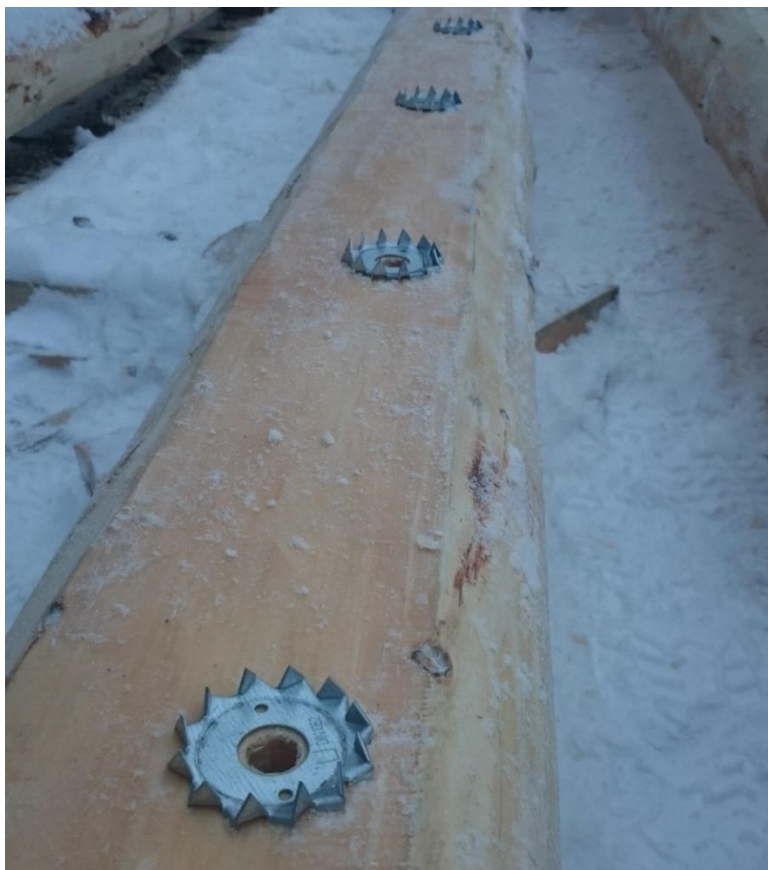
KUVA 32. Hammaslevyt asennettuna alempaan puuhun (Eskelinen 2015)
