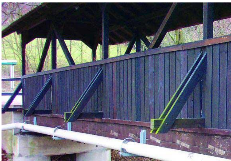
KUVA 6. Puusilta Itävallassa, jossa massiivipuinen vaarnapalkki (Brungraber & Miller 2009)
